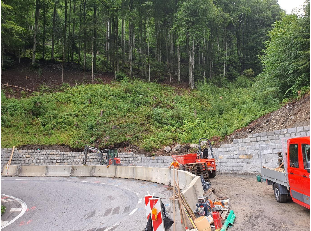
Gut ersichtlich die Strassenverbreiterung und die neu erstellte Natursteinmauer
