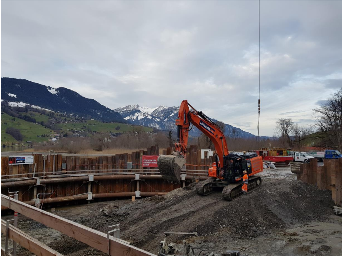
Foto 3: Baugrube Einlaufbauwerk (Bild: Bau- und Raumentwicklungsdepartement, 31. Januar 2020).
