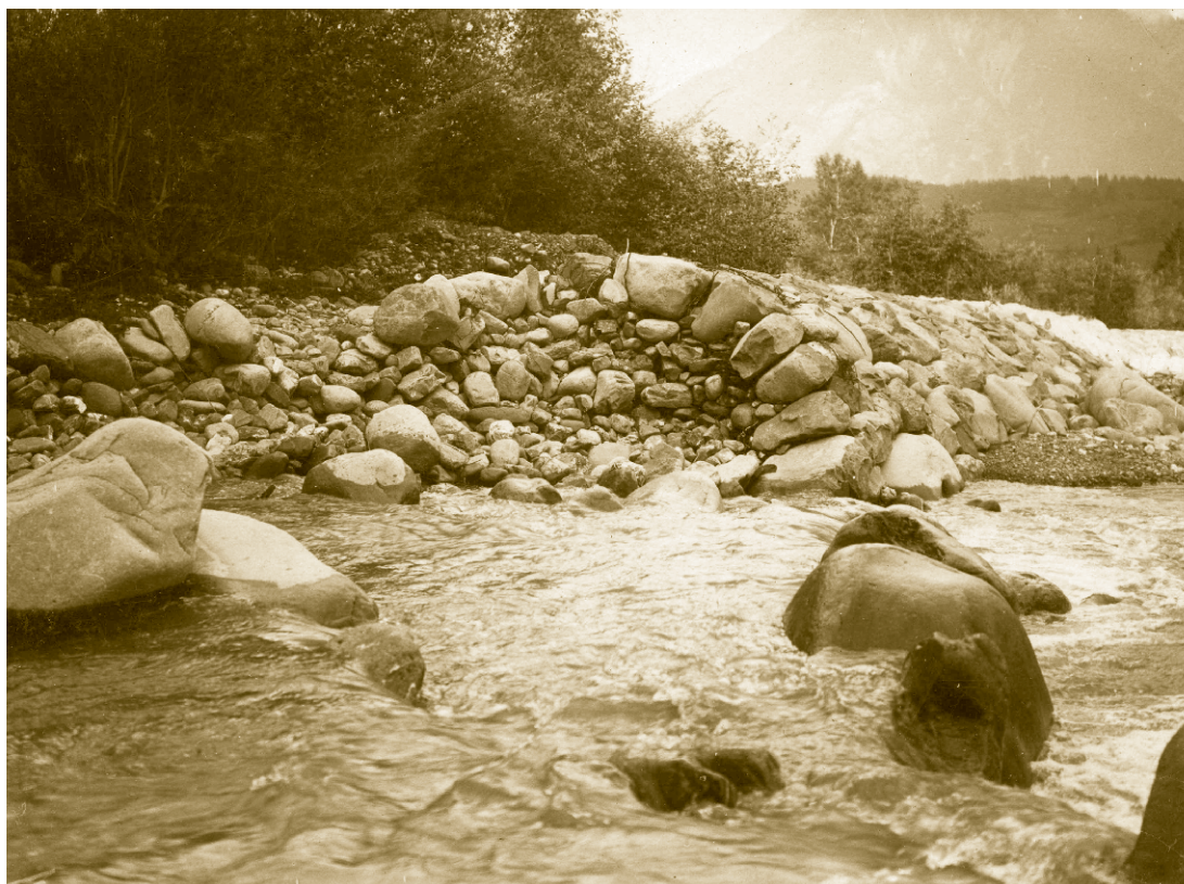
Abb. 2: StAOW E.0207.19.253. Zerstörtes linksufriges Wuhr bei der Grossen Schliere unterhalb der Strassenbrücke (1902).
