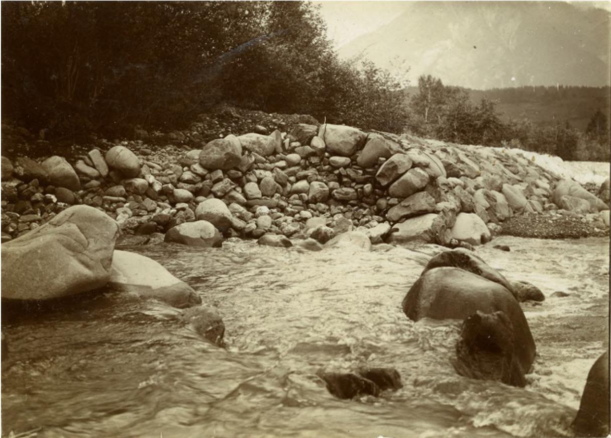
Abb. 1: Zerstörtes linksufriges Wuhr bei der Grossen Schliere unterhalb der Strassenbrücke, 1902 (E.0207.19.253 (5)).
