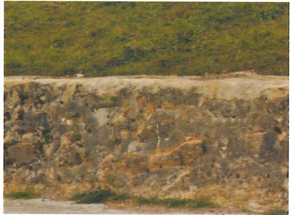
Betonierte, verfugte Stützmauer mit Natursteinen
