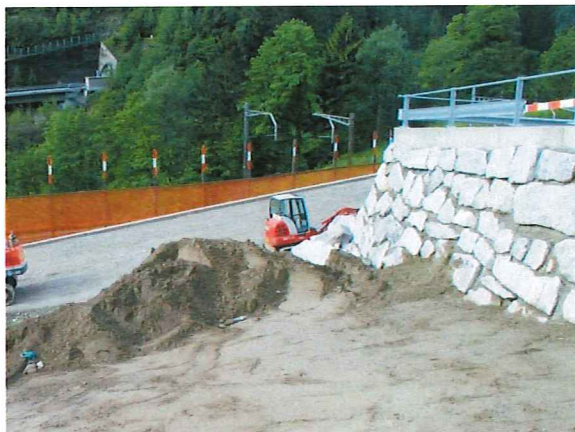
Moderne, mit Maschinen errichtete Zyklopenmauern
