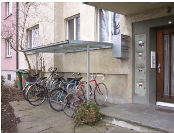
Abb.6: Nahe am Eingang, überdacht und Velorahmen anschliessbar. Diese Anlage ist für Kurz- und Langzeitparkierung geeignet.
