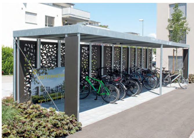
Abb.9: Veloparkplätze in Nebengebäuden sind besser zu erreichen und günstiger zu erstellen als in Untergeschossen.
