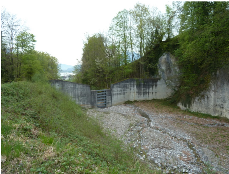
Abbildung 4: Sigetsbachsammler im aktuellen Zustand, ohne Holzurückhalt.
