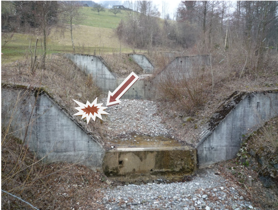
Abbildung 5: Sigetsbach-Unterlauf gesichert mit Betonsperren.
