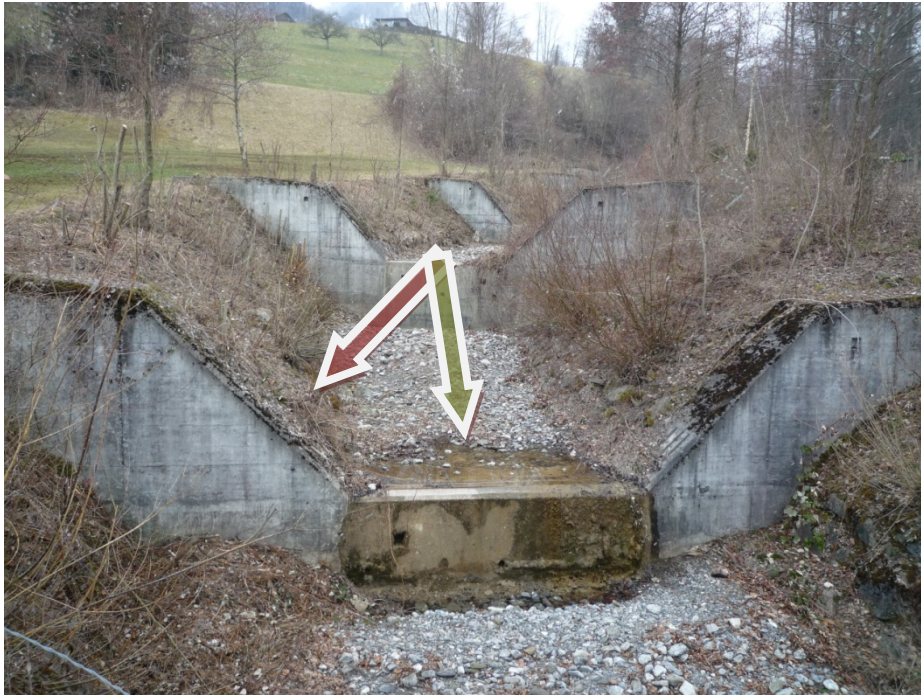
Abbildung 8: Massnahmen im Sigetsbach-Unterlauf, insbesondere Korrektur von Sperren.
