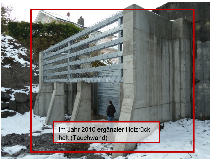
Abbildung 3: Im Jahr 2010 erstellter Holzurückhalt (Tauchwand) im unteren Geschiebesammler des Spisbachs.
