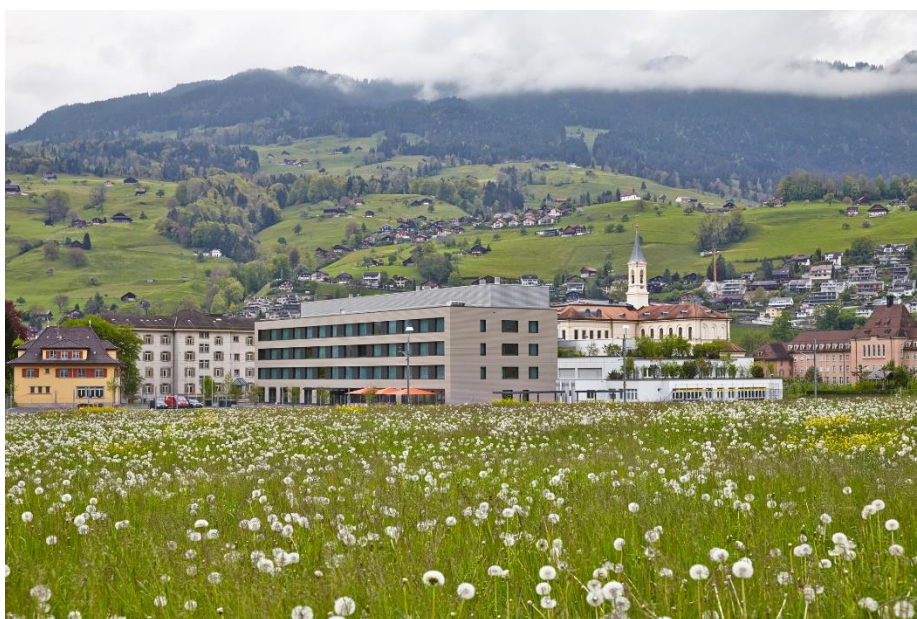
Bild: Der im Mai 2014 in Betrieb genommene neue Bettentrakt des Kantonsspitals Obwalden
