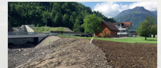
Massnahme: Bau Geschiebesammler und neues Gerinne
