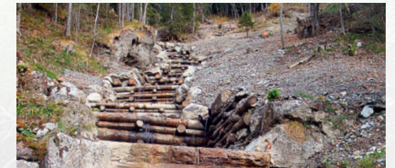
Sohlenstabilisierung mit Holzsperrn
