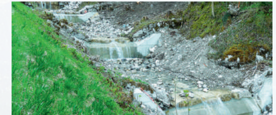
2 Bachsohlenstabilisierung mit Betonschwellen
