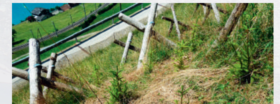
Aufforstung und Gleitschneeschutz mit Dreibeinböcken
