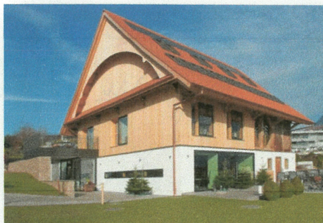
Scheune nachher (Umbau):
