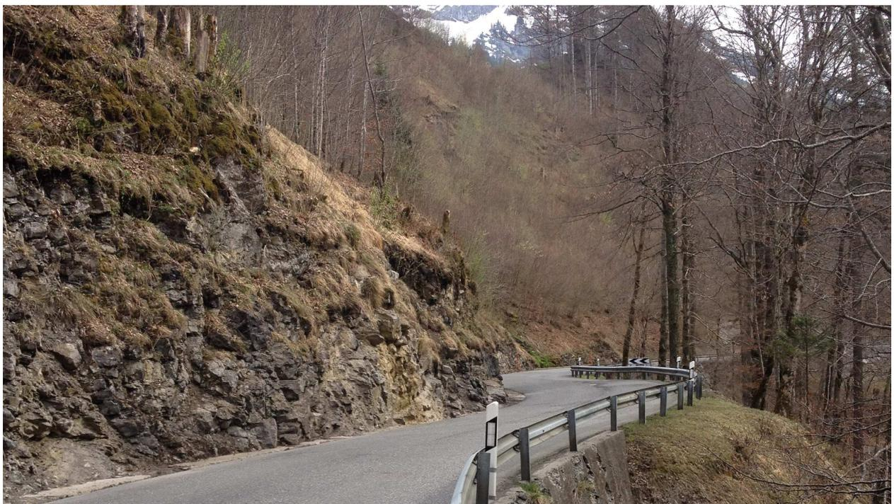
Foto 2, April 2014: Engste Stelle auf der gesamten Strecke mit einer Strassenbreite zwischen 5,20 m und 5,45 m.
