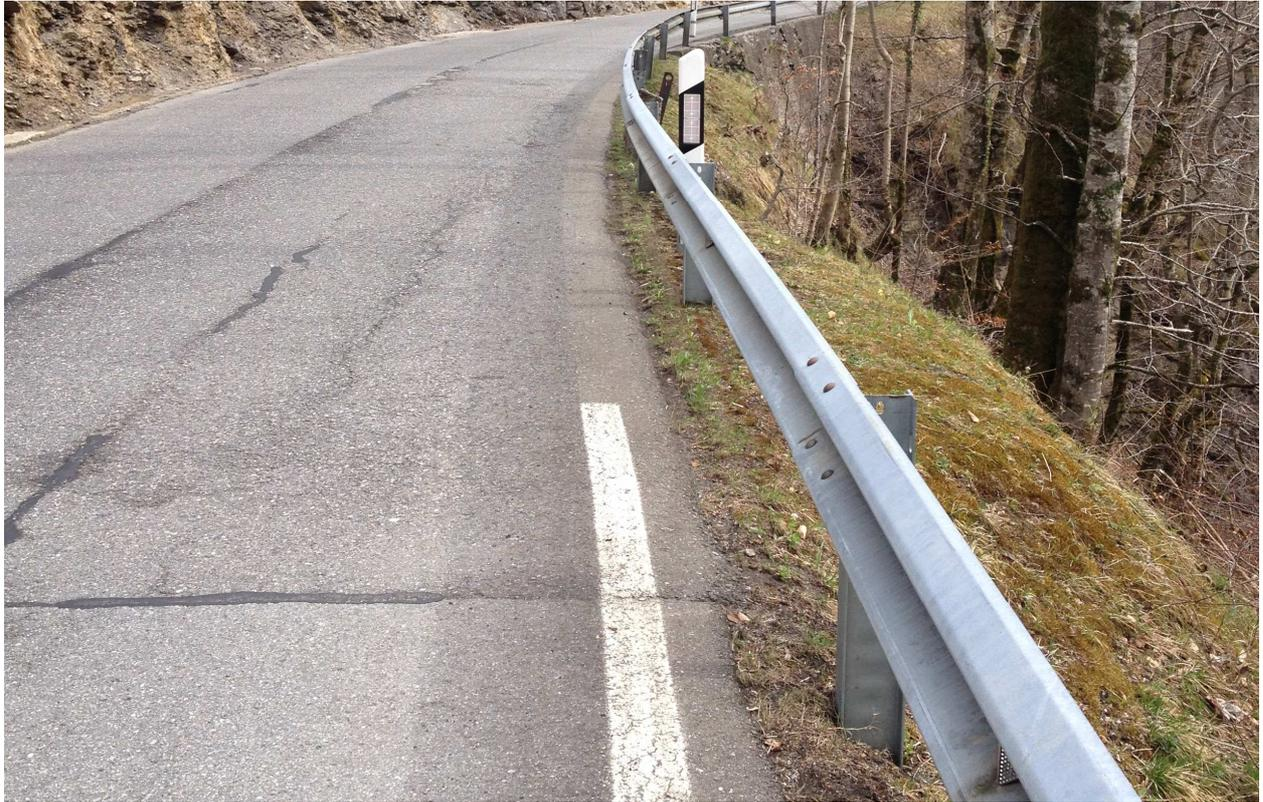
Foto 3, April 2014: Schadhafte Belagsoberfläche mit Belagsflicken, Rissen und Absenkungen.
