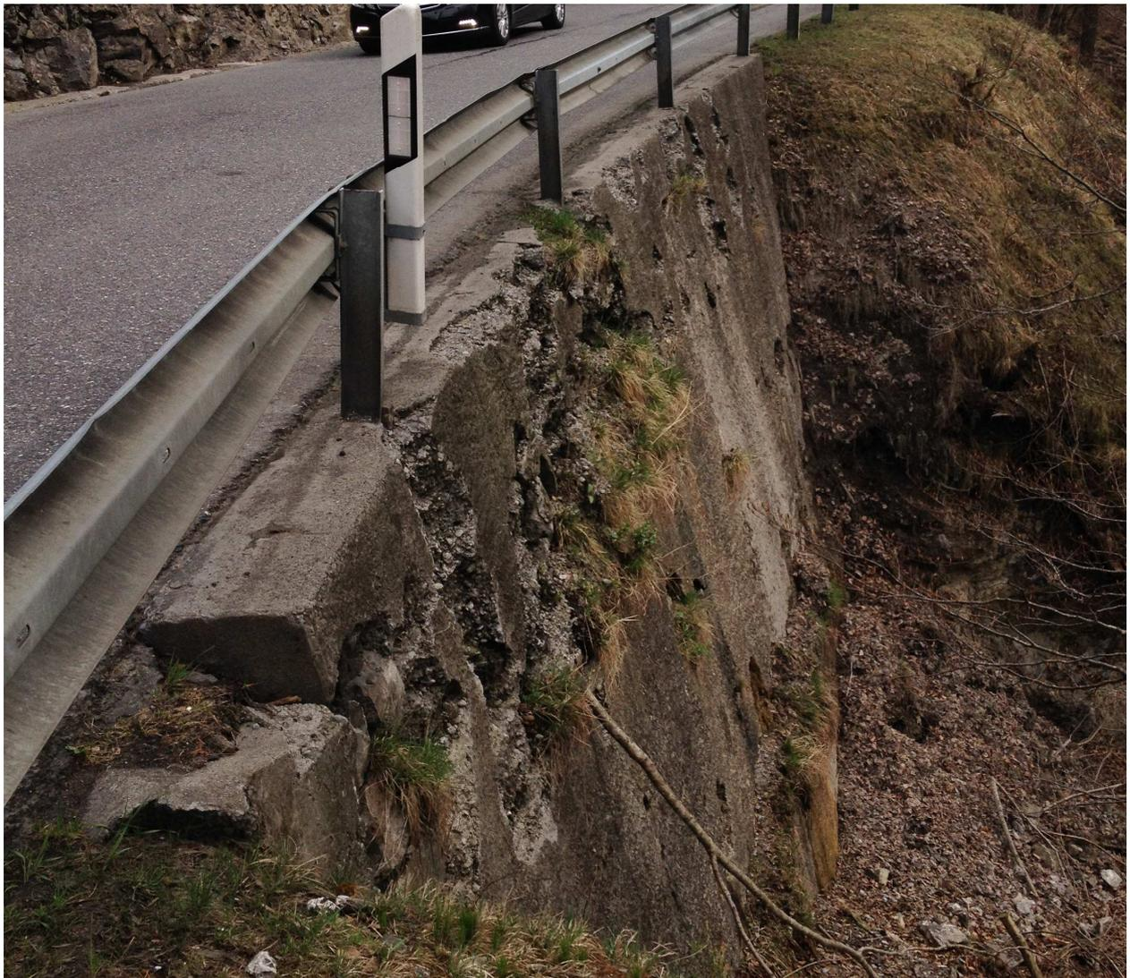
Foto 4, April 2014: Talseitige Betonstützmauer in der Engstelle in einem sehr schlechten Zustand. Steil abfallendes Gelände. Mangelhafte Absturzsicherung.
