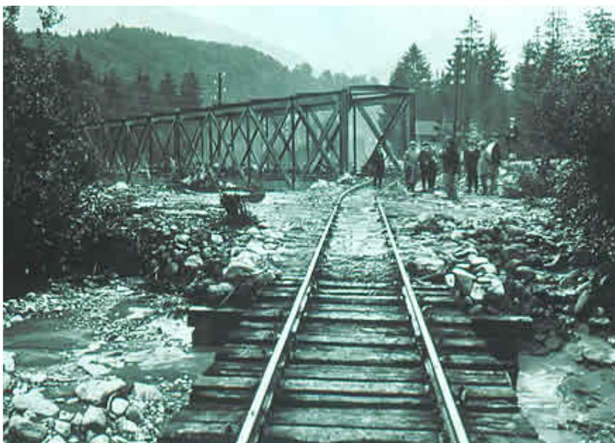
Hochwasser der **Grossen Schliere** vom 5.8.1931 (grosse Schäden, Eisenbahnbrücke durch Wasser und Geschiebe weggespült)
