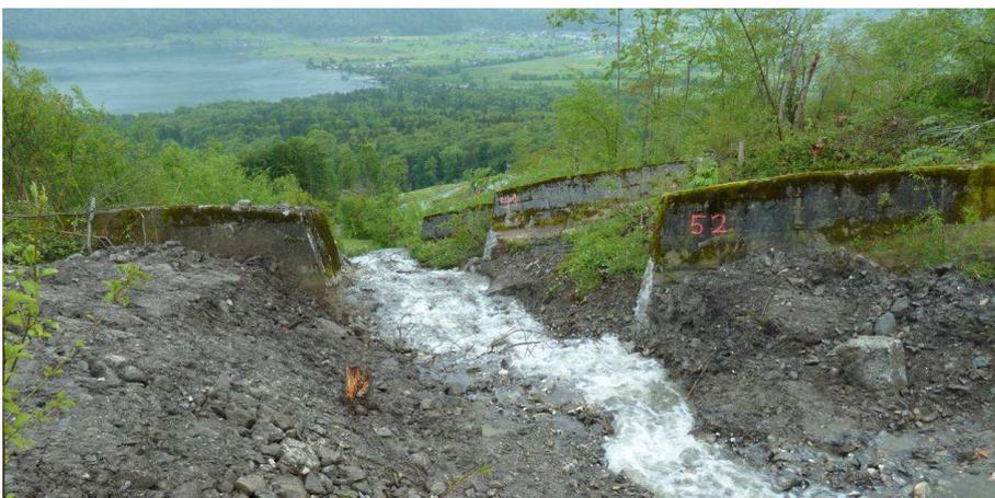
Abbildung 9: Absenken der Überfallkanten an einzelnen Sperren des Schlimbachs, damit das Wasser nicht in das abgesenkte Gelände neben dem Bach ausbrechen kann.
