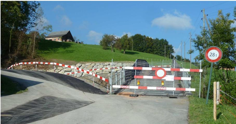
Abbildung 4: Sperrung der verschobenen Brücke der Schlimbachstrasse und Ersatz durch eine Furt links.
