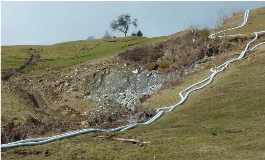
Abbildung 8: Fassen und Ableiten des Golpigräblis in Rohren, damit weniger Wasser an den Anrissstellen in die Rutschhorizonte einsickert.
