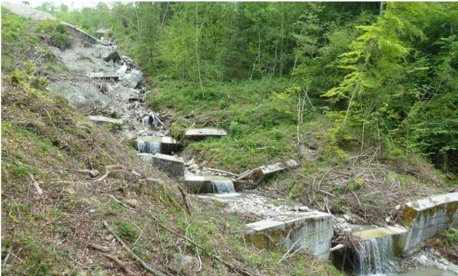
Abbildung 5: Zerstörung von Betonsperren im Schlimbach.
