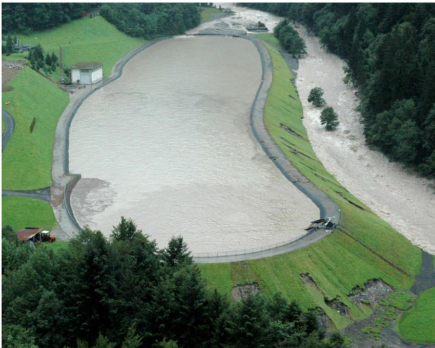
Abbildung 2: Beispiel beginnender Dammerosion nach kurzzeitigem Überströmen der Dammkrone am Ausgleichsbecken Obermatt, Gemeinde Engelberg, 23. August 2005. Durch eine anschliessende Veränderung der Abflusssituation der Engelbergeraas am Einlaufbauwerk des Ausgleichsbeckens wurde die Situation entschärft und der Kollaps des Ausgleichsbeckens unterblieb glücklicherweise.
