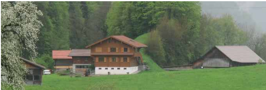
Dachflächen sind nur mit wenigen einzelnen Dachfenster bespielt.
