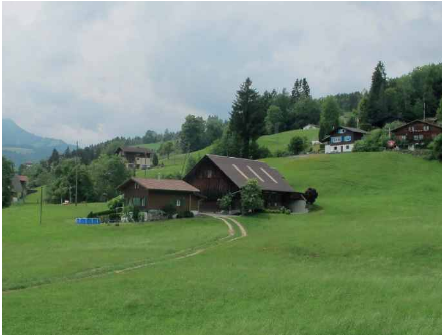
Die Reduktion des Weges auf befestigte Fahrleisen stellt eine sensible und landschaftsschonende Weggestaltung dar, mit einem Minimum an Oberflächenversiegelung.
