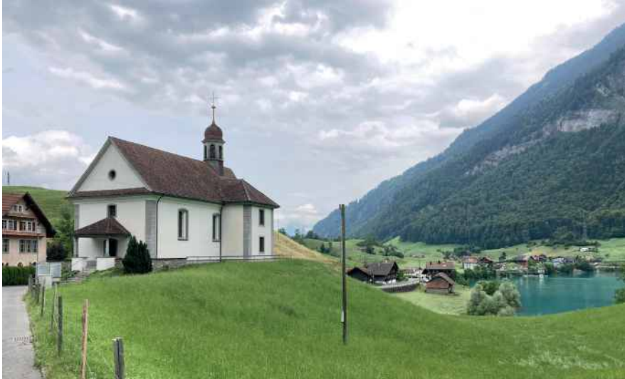
Die Kapelle in Bürglen liegt sehr exponiert auf einer leicht erhöhten Hügelkuppe und zudem weit einsichtig an einer Wegbiegung. Sie markiert einen wichtigen Ort, der zugleich Orientierung im Gebiet bietet.
