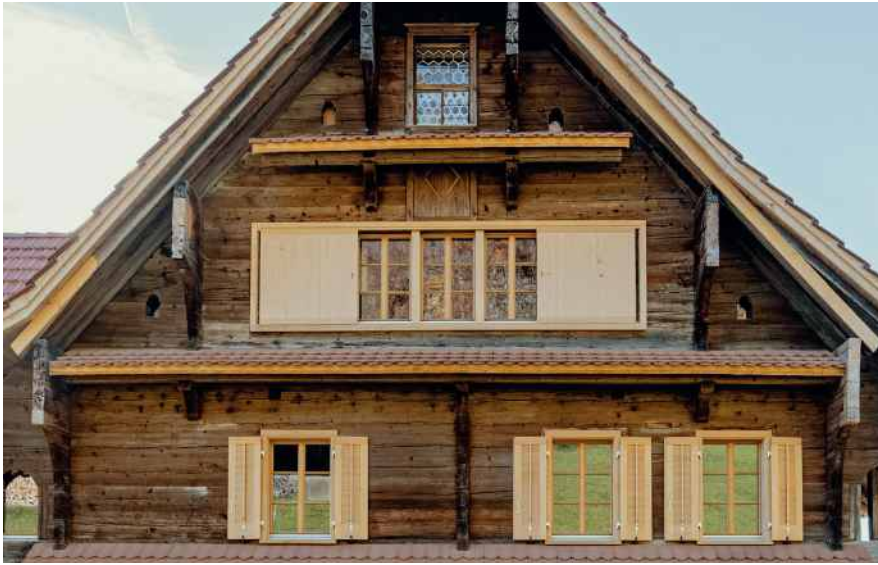
Aussenansicht eines traditionellen Zugladers (Oben), einer modernisierten Fensterreihe mit Schiebeläden (Mitte) sowie klassischen Klappläden (Unten). Umbau Haus Büchholz (Imhof Architekten)
