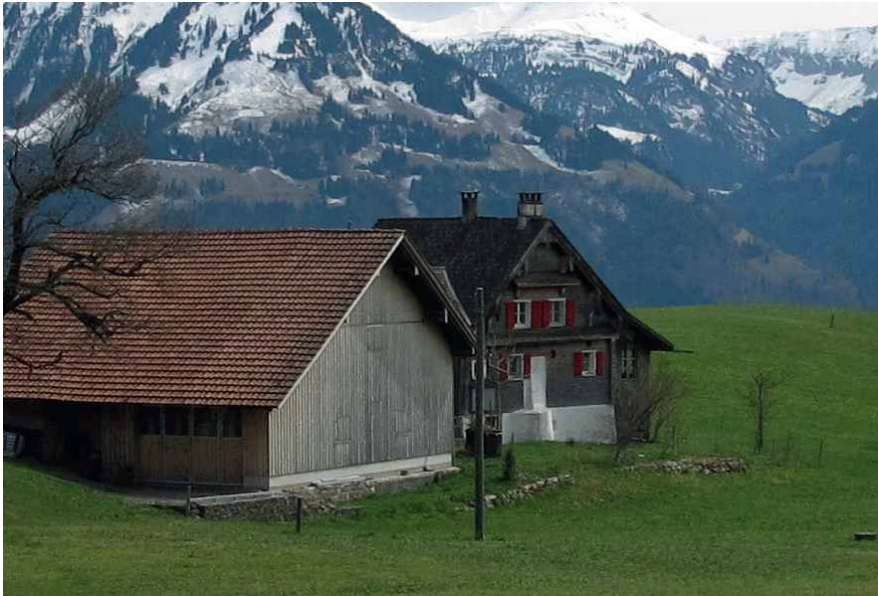
Beispiel einer zurückhaltenden Trockenmauerwerkswand, die sich gut in die Wiesenlandschaft einbettet. Die auslaufende Lesesteinmauer schafft einen flachen Bereich für den Betriebsablauf.
