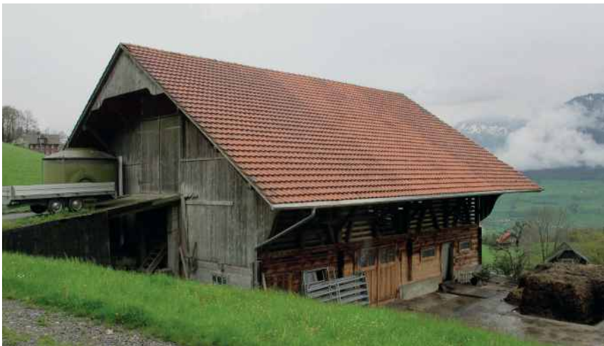
Typische Organisation eines Stallgebäudes über mehrere Ebenen und kaum auffallendem Silo neben der Tennenauffahrt. Türen und Tore sind Teil der Holzfassade und gleicher Materialität.
