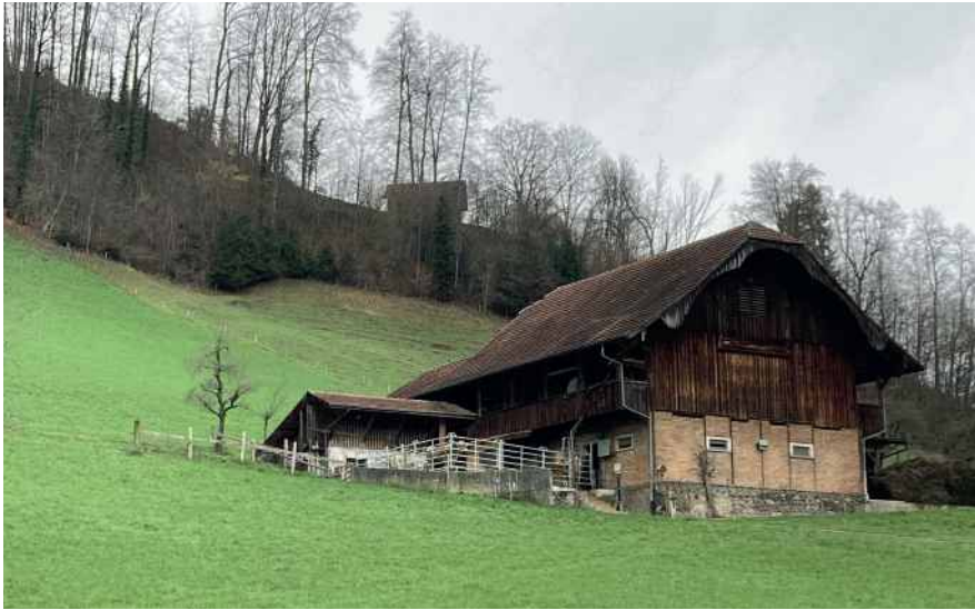
Kleine baukulturelle Detaillierungen wie die geschwungene hölzerne Giebelverblendung führt zu einer hohen Wertigkeit bei dem historischen ansonsten funktionalen Landwirtschaftsbau. Die neue Anforderung des nachträglich ergänzten Freilaufplatzes fügt sich zurückhaltend in den Bestand ein und erlaubt einen Weiterbestand des Stallgebäudes.
