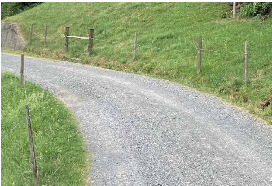
Die Weidezäune sind typischerweise aus gespaltenen und angespitzten Fichtenstämmen (unbehandelt) mit einem gespannten Draht.
