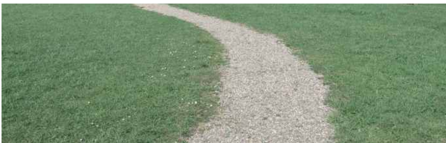
Schotterweg mit weichen Übergängen (ohne Randsteinabschluss)
