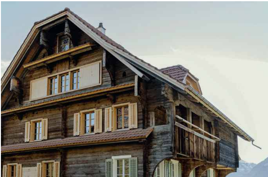
Beispiel einer zurückhaltenden (renovierten Bestands-) Lukarne, welche die klare Gesamtform des Daches nicht beeinträchtigt und ausreichend Versatz zu First und Traufe aufweist. (Haus Büchholz, Imhof Architekten)
