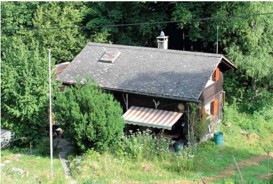
Für das Brüniggebiet typische als Ferienhäuser genutzte Bauten
