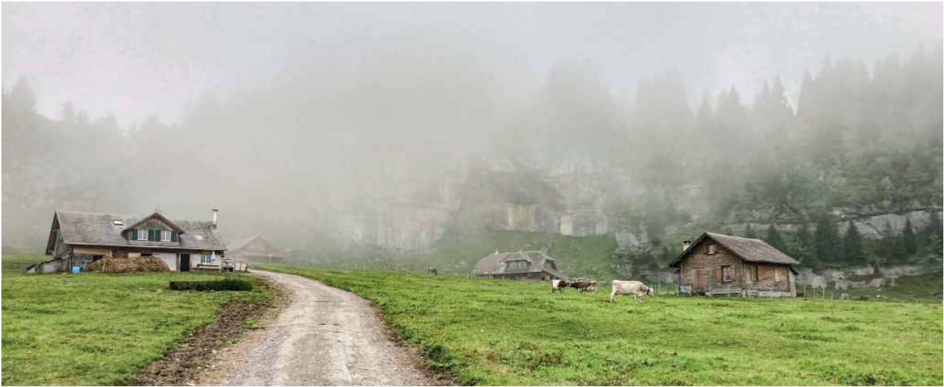
Harmonisches Ensemble von Alpgebäuden mit rückwärtigem Steilhang
