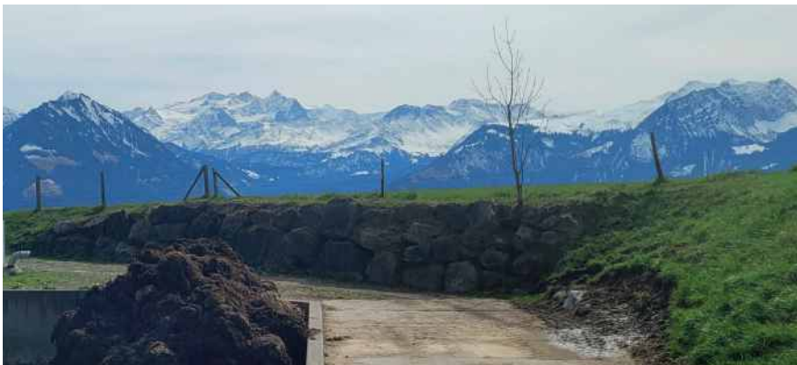
Für eine Stallzufahrt notwendige Mauer wurde minimal gehalten. Im flacheren Gelände wurde auf eine Böschung gewechselt.
