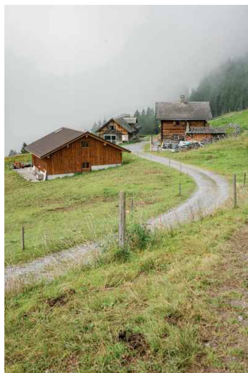
Harmonisch wirkende Gruppierung an Bauten einer Alp unterschiedlichen Baualters
