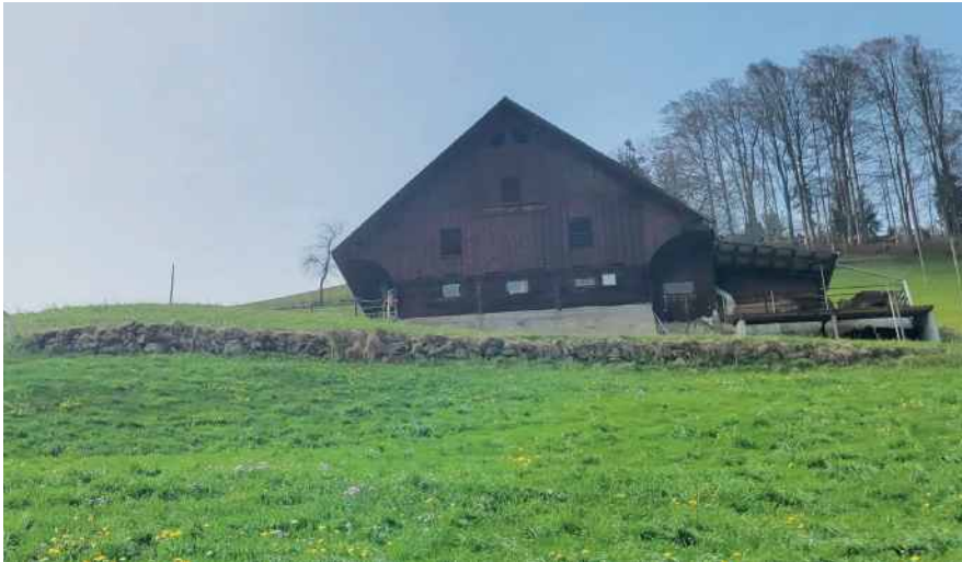
Eine auf das technisch unbedingt notwendige Mass reduzierte Natursteinmauer, die sich durch ihre trockene Bauweise und ihren Bewuchs in den offenen Fugen und die Überdeckung mit Erdrich gut in die Wiesenlandschaft einfügt.
