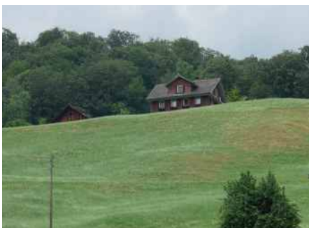
Typische Gebäudeansicht - nur oberer Teil des Gebäudes sichtbar
