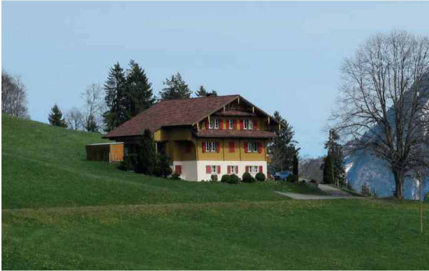
Ortstypisches Wohnhaus mit flach geneigtem Dach (Tütschdach) und symmetrisch gegliederter Fassade.
