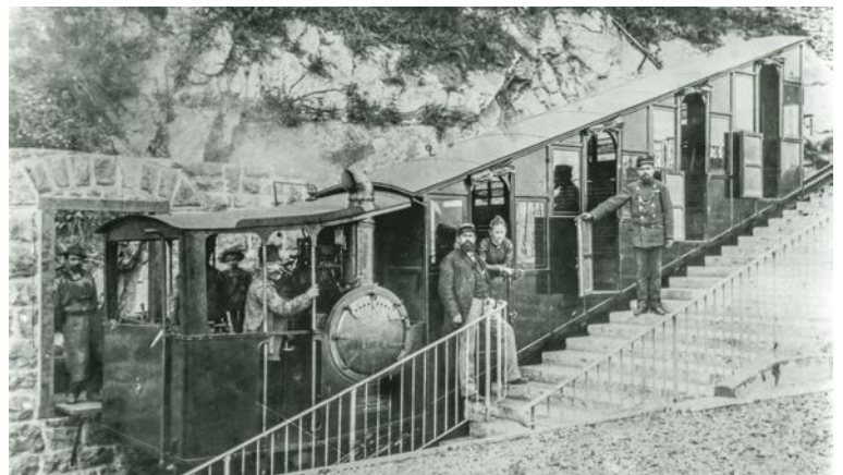
Von Dampf zu Strom: Seit 1889 erklimmt die Pilatusbahn den Berg, seit 1937 elektrisch – und seit 2023 mit neuen Triebwagen, die Effizienz und Betriebssicherheit weiter erhöhen.
