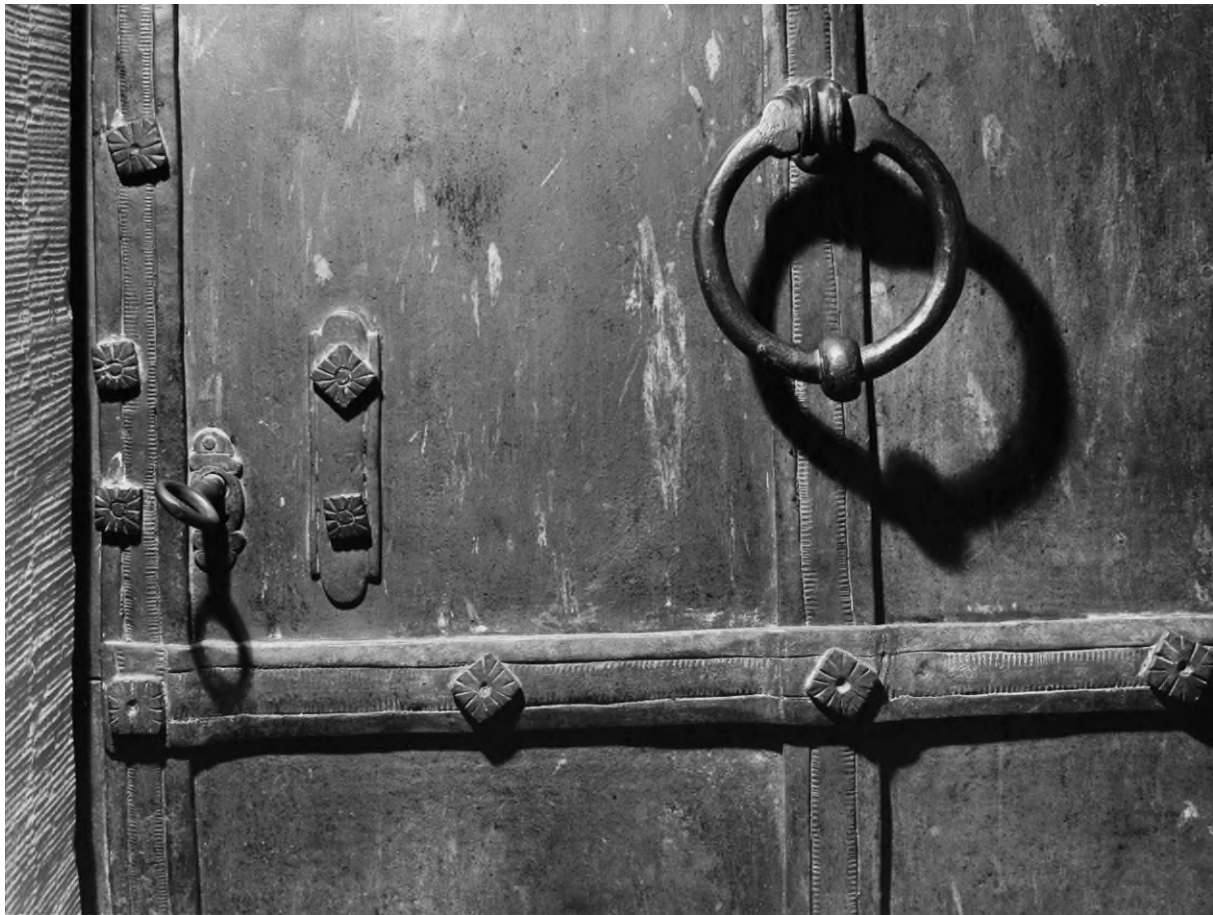
Abb. 3: Rathaus Sarnen, Detail der Archivtüre vor der Renovation 1977/78. Fotograf: O. Pfeifer, SWB, Luzern ( D.03.0253.04.65 ).
