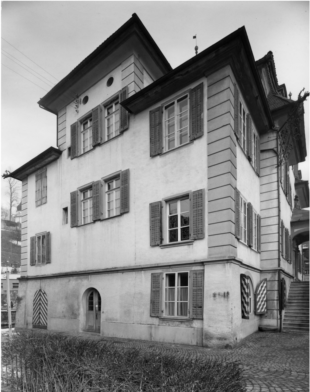
Abb. 2: Südostfront des Rathauses vor Renovation 1977/78 mit Archivanbau von 1787 (links), Treppenhaus (Mitte) und Anbau von 1949 (rechts). Fotograf: O. Pfeifer, SWB, Luzern ( D.03.0253.04.15 ).
