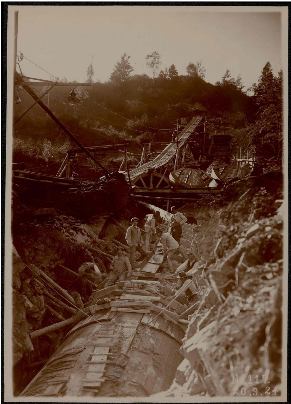
Abb. 13: Zweiter Ausbau: Arbeiter bei Betonarbeiten an der zweiten Druckleitung, 20.09.1924
