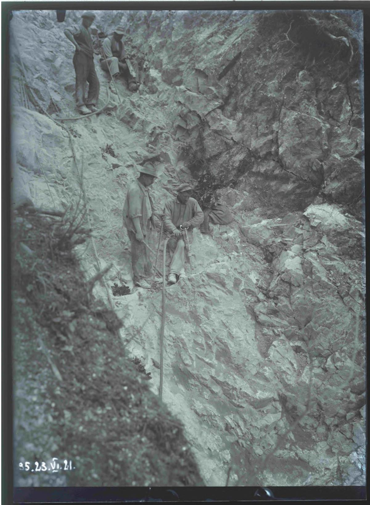
Abb. 1: Arbeiten am Felseinschnitt für die Druckleitung, 23.05.1921 ([StAOW E.0322.04.10.033 \(05\)](#)).
