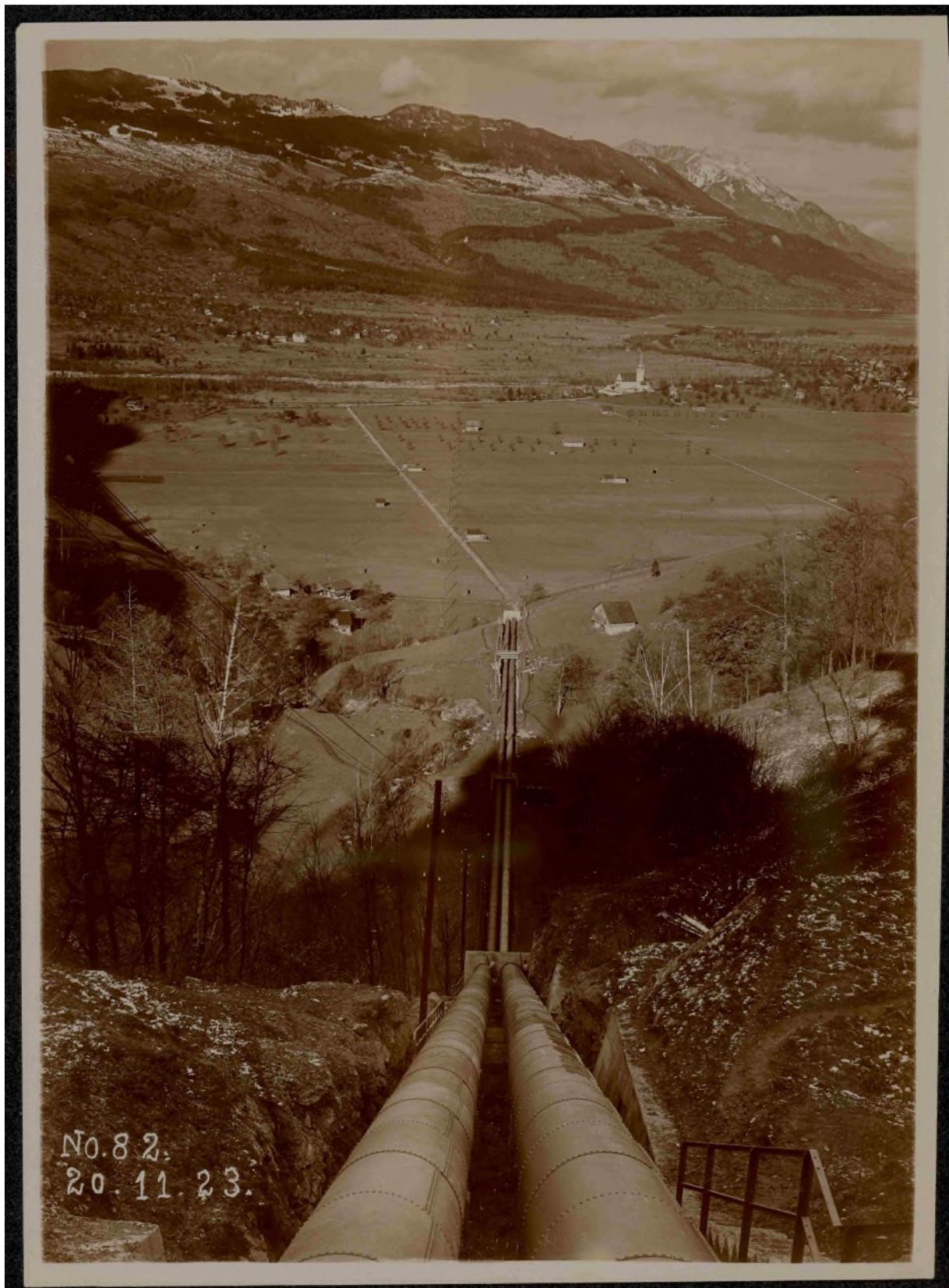
Abb. 14: Zweiter Ausbau: Blick von der Apparatekammer auf die beiden Druckrohre, im
