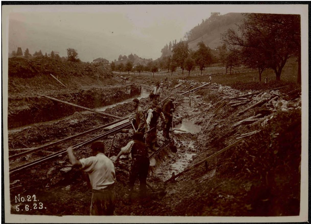
Abb. 11: Zweiter Ausbau: Aushubarbeiten im Rahmen der Aakorrekction in Giswil, 06.05.1923 (StAOW E.0322.04.11.021 (05)).
