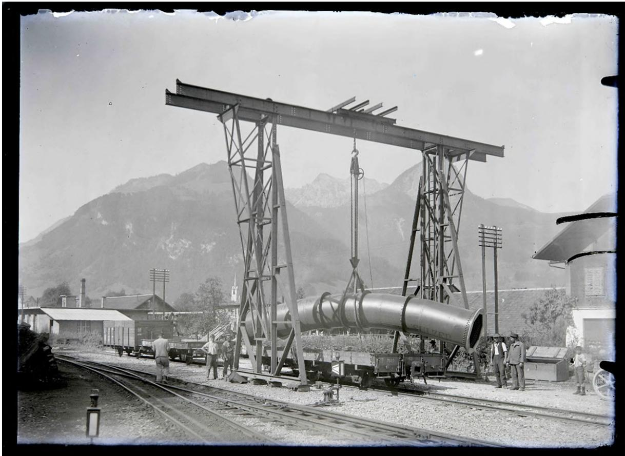
Abb. 3: Umladen eines Druckleitungselements am Bahnhof Giswil, ca. 1921 ([StAOW E.0322.04.10.106 \(05\)](#)).
