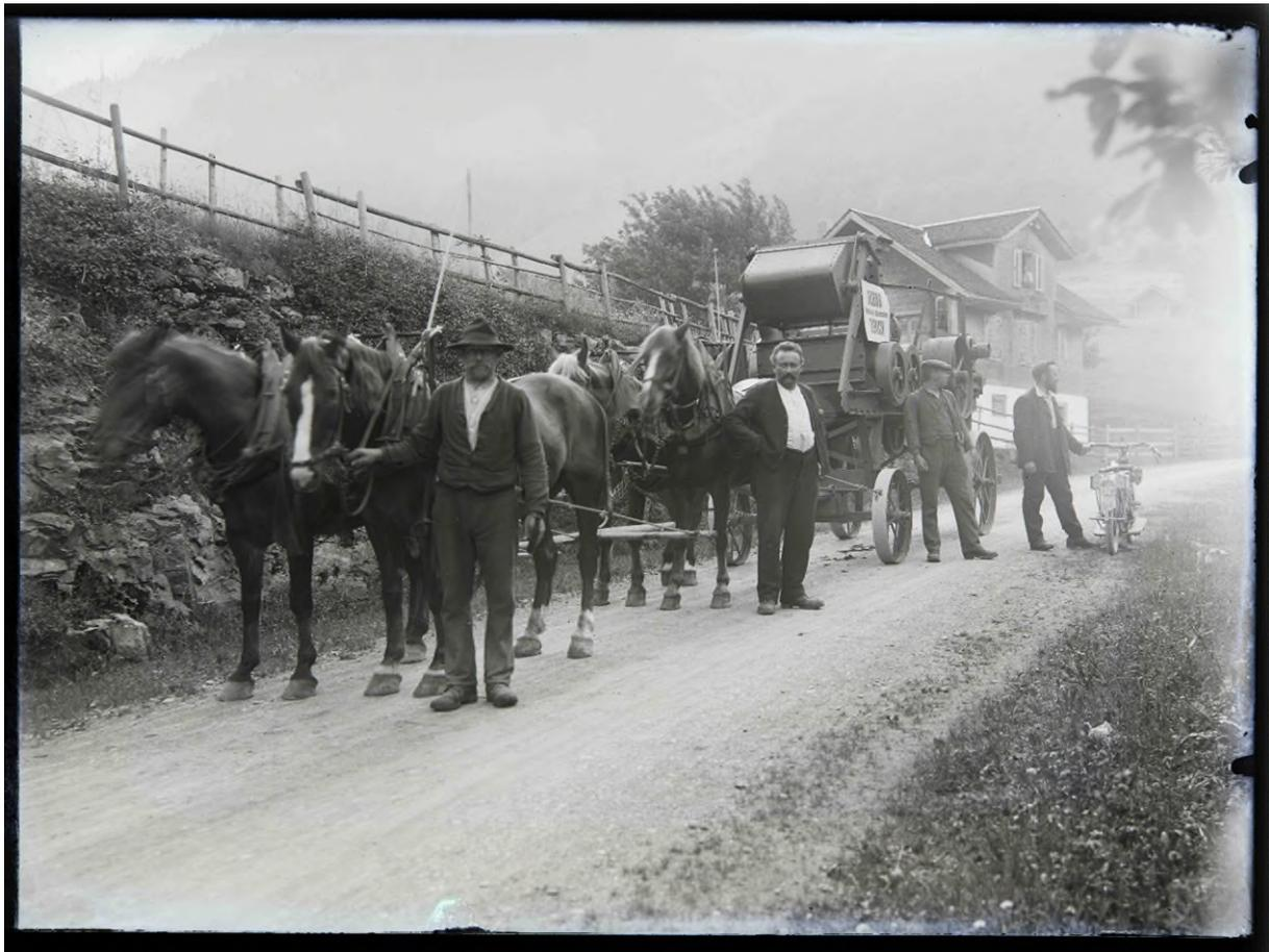
Abb. 7: Erster Ausbau: Transport von Baggerteilen mit Pferdefuhrwerk auf der Strasse
