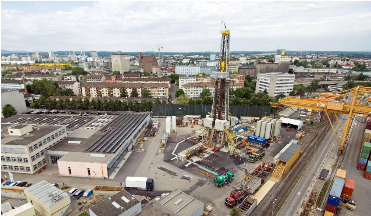
Abb. 57 Bsp. für eine Bohranlage für grosse Tiefen
