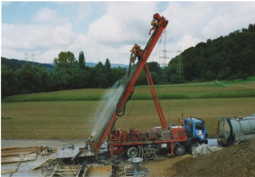
Abb. 56 Erschliessungsbohrung in Itingen
