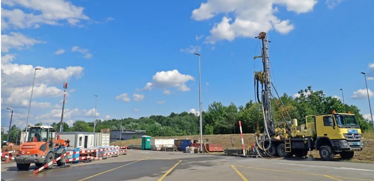
Abb. 55 Bohrplatz und -anlage für Tiefen bis ca. 400 m
