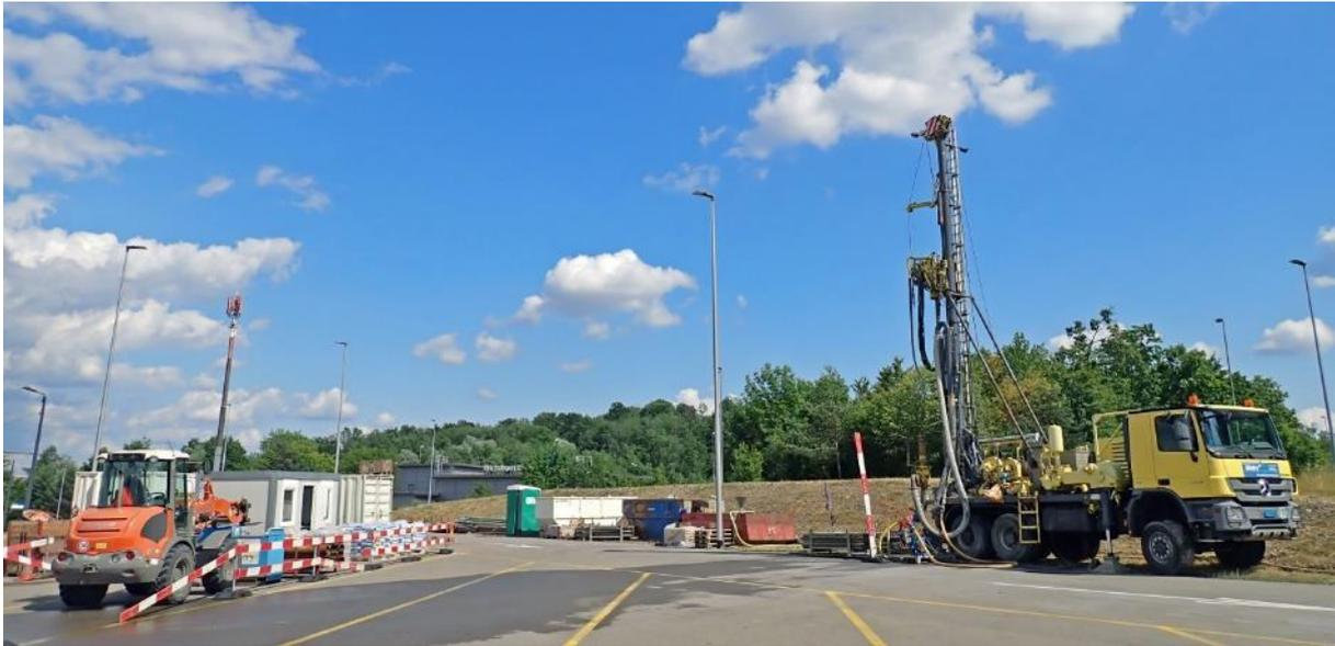
**Abb. 55 Bohrplatz und -anlage für Tiefen bis ca. 400 m**
