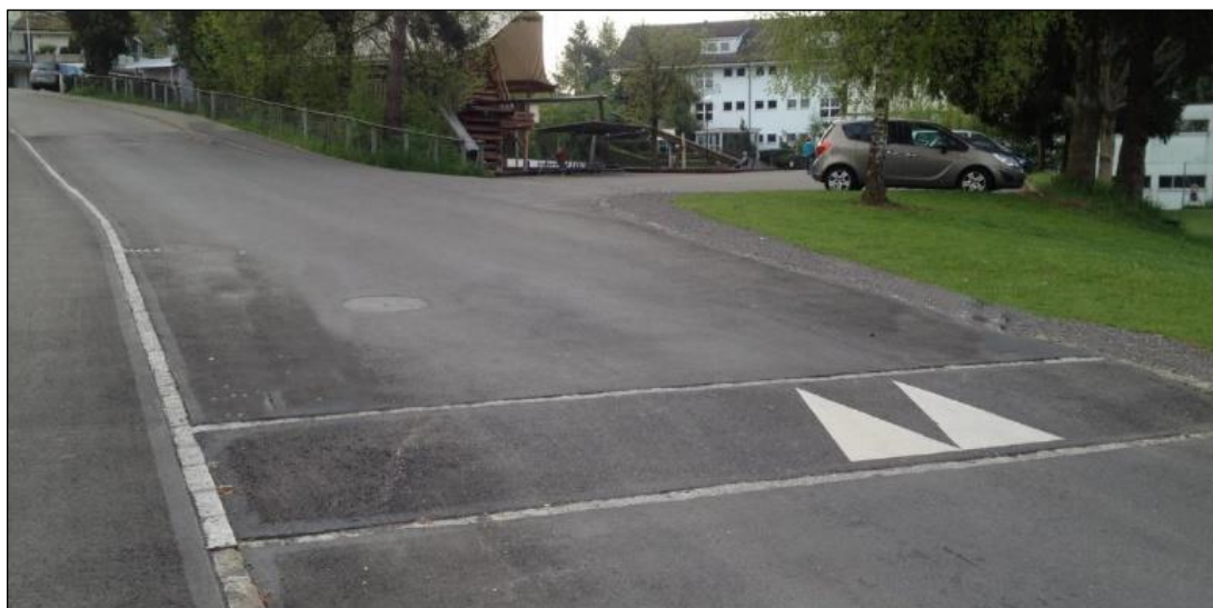
Abb.8 Gestaltungsbeispiel Knoten mit angehobener Fahrbahn
