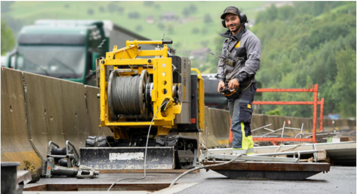
Im Rahmen der Bauarbeiten für den 2,1 Kilometer langen neuen A8 Tunnel Kaiserstuhl verlegten die Mitarbeitenden des Bereichs Netzbau während verschiedener Bauphasen Leitungen. Im Mai 2023 zog Netzelektriker Raphael Pfister zusammen mit seinen Kollegen im Gebiet Kaiserstuhl mit der Zugwinde neue 16 kV-Leitungen in bestehende Rohranlagen ein und installierte neue Anschlüsse.
