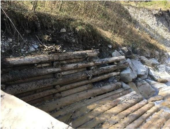
Abbildung 2: Beschädigtes Seitenleitwerk/ Holzkasten unterhalb der Furt Rütimatt
