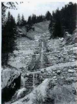
Verbauung des Ei- und Gadenmattbaches in Lungern (1888–1895)
