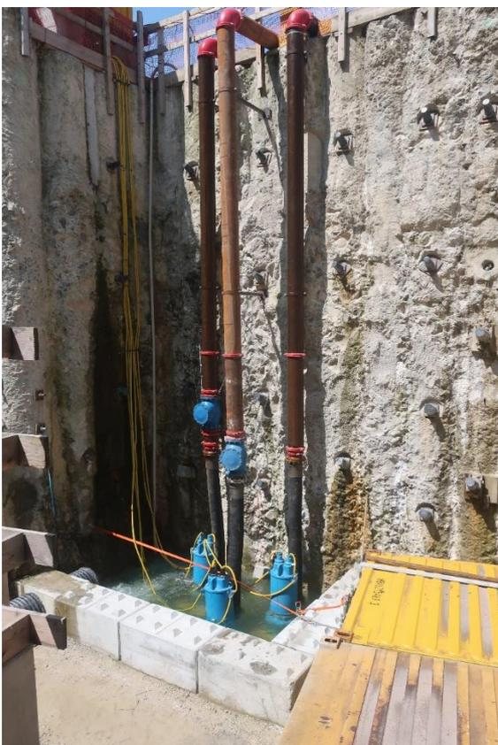
Abbildung 11: Havariepumpen beim Startschacht.
