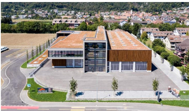
Links wellenförmige Garageneinfahrt, rechts Lärmschutzwand (Foto von Rohr Holzbau AG Egerkingen)
