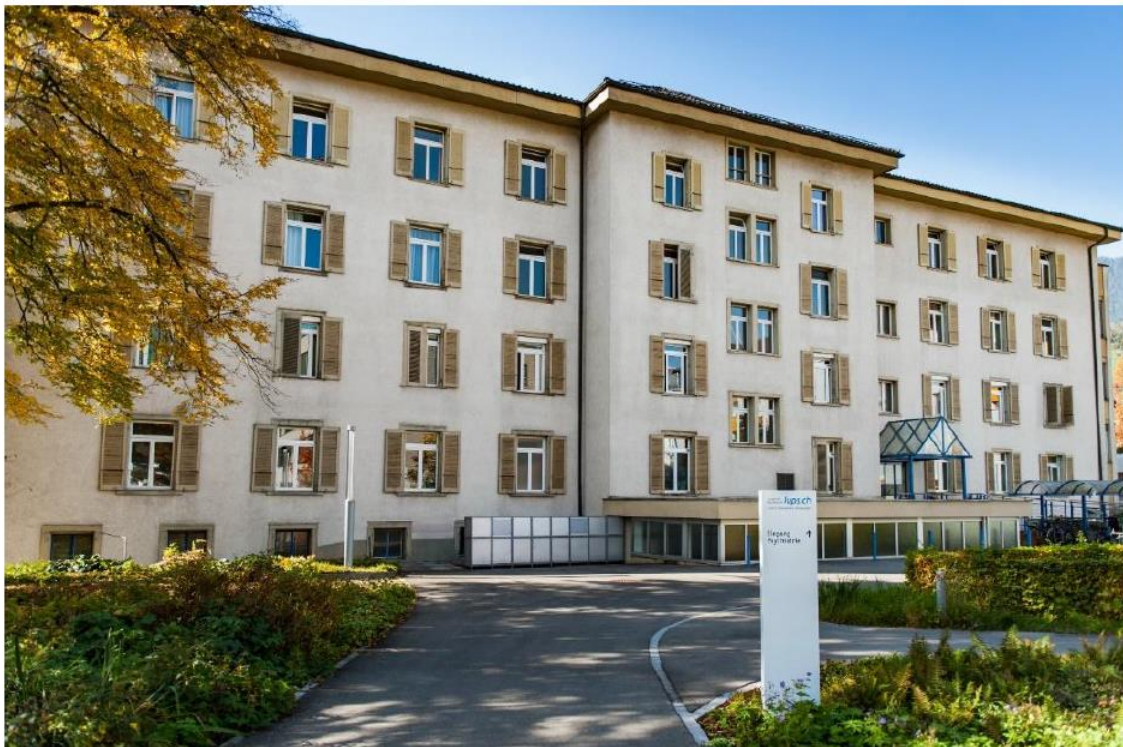
Abbildung 1: Psychiatriegebäude, Ansicht Ost
