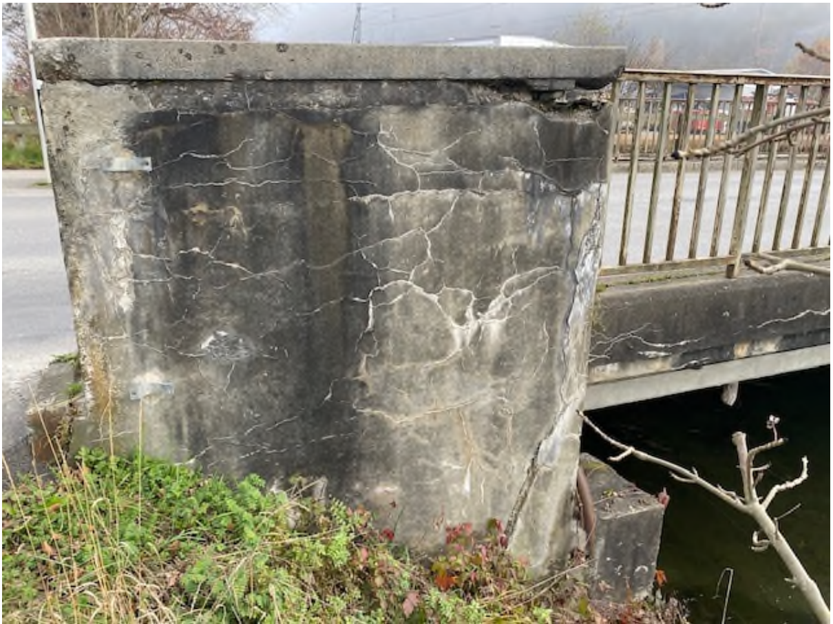
Widerlager Seite Kägiswil (oberwasserseitig)
