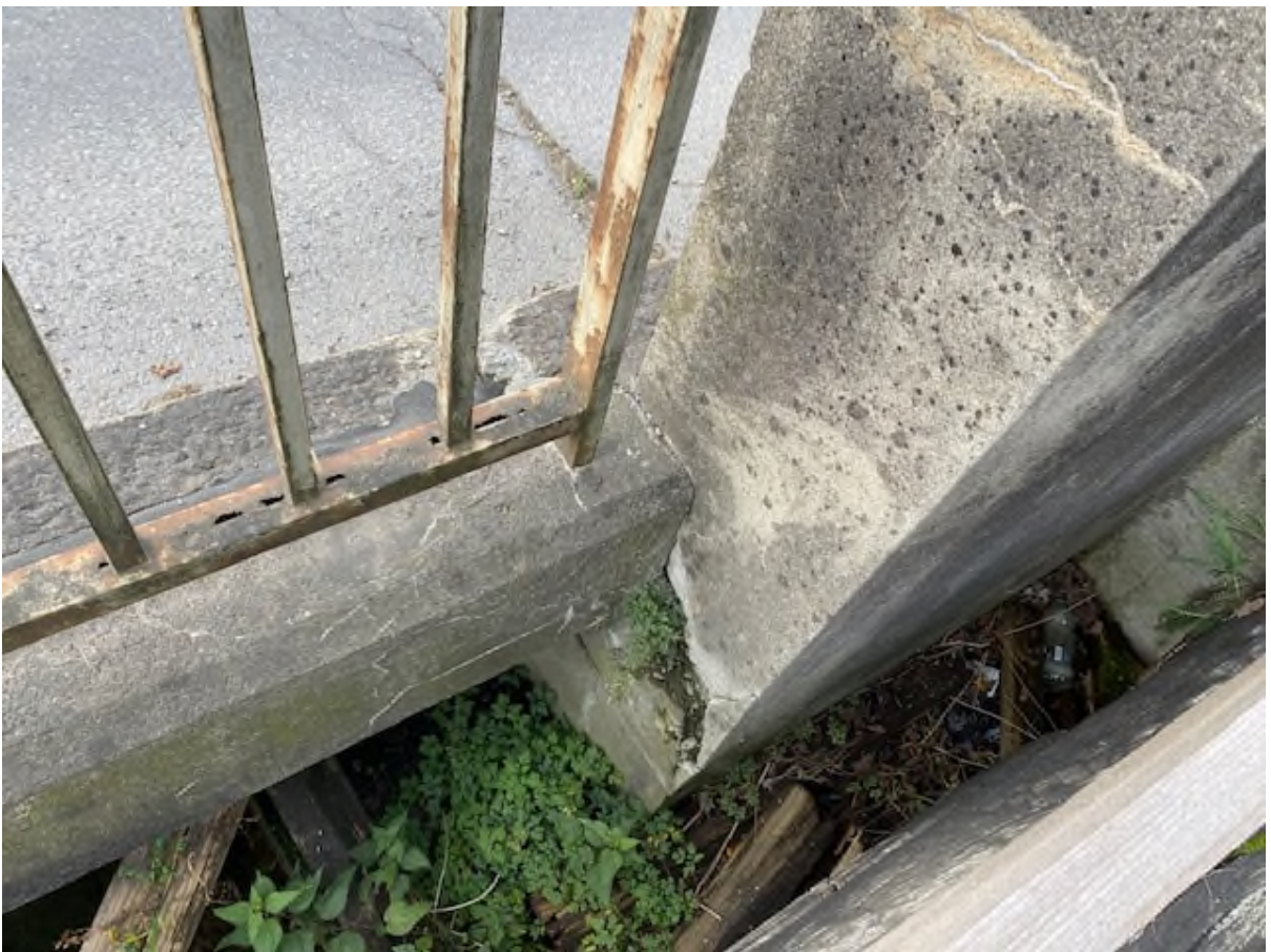
Widerlager Seite Kägiswil (unterwasserseitig)
