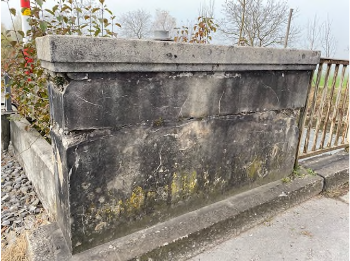
Widerlager Seite Chernmatt (oberwasserseitig)
