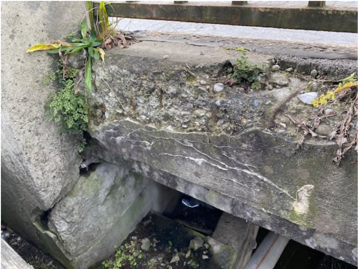
Widerlager Seite Chernmatt (unterwasserseitig)
