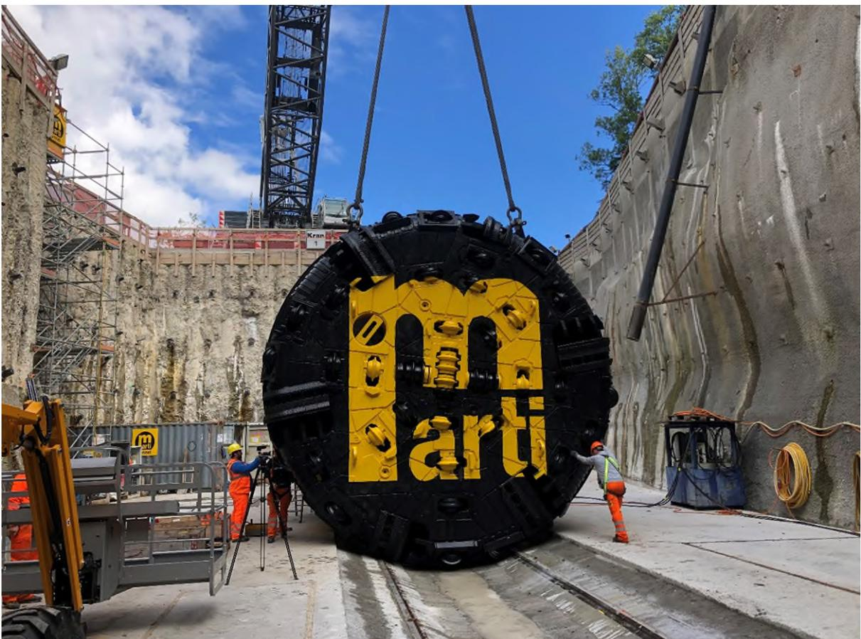
Bild 4: Der Bohrkopf wird in die Baugrube gehievt und anschliessend an der Tunnelbohrmaschine montiert. (Bilder Amt für Wald und Landschaft Obwalden)
