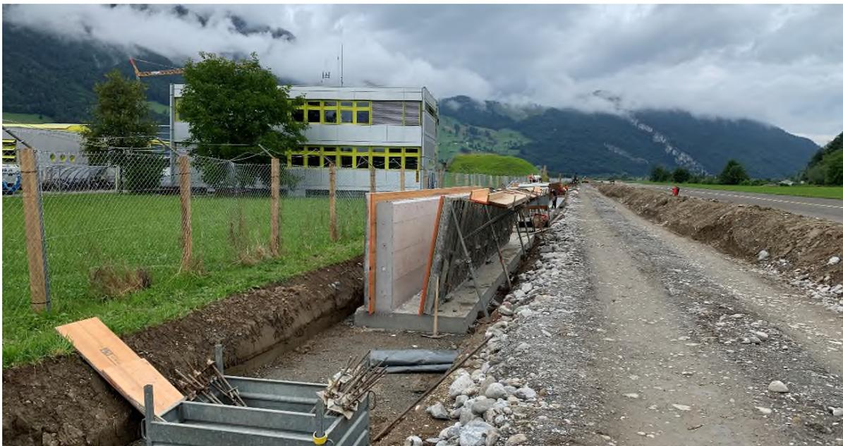
Die sich im Bau befindende Hochwasserschutzmauer entlang der Infrastrukturanlagen des Flugplatzes Alpnach schützt diese vor zukünftigen Hochwassern.
