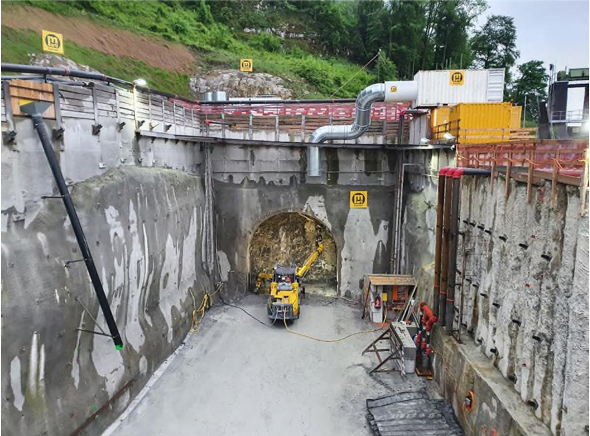
Bohren der Sprenglöcher für den Vortrieb der Startröhre in der Baugrube Auslaufbauwerk unmittelbar unterhalb der Wehranlage Wihelsee, Gemeinde Alpnach.
