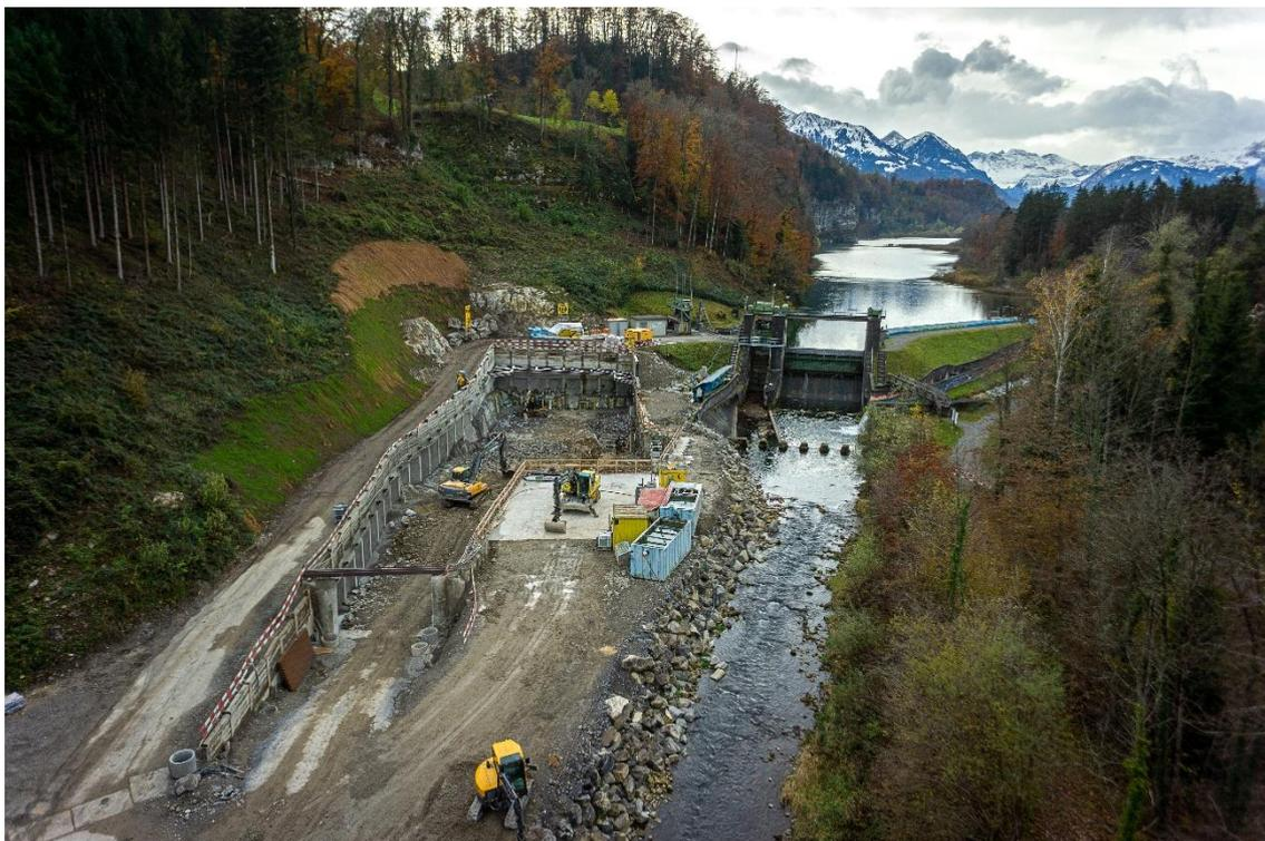
Abbildung 3: Baugrube Auslaufbauwerk unmittelbar unterhalb der Wehranlage Wichelsee, Gemeinde Alpnach.
