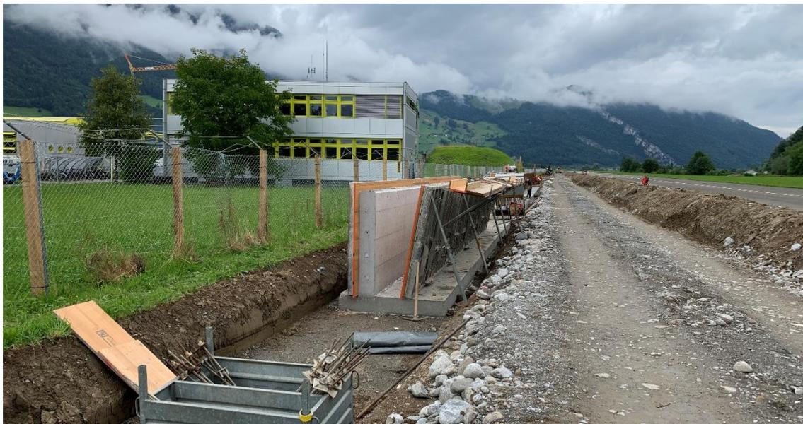
Abbildung 6: Bau der Hochwasserschutzmauer entlang der Infrastrukturanlagen des Flugplatzes Alpnach (Foto: R. Hegglin, 16. Juli 2020).
