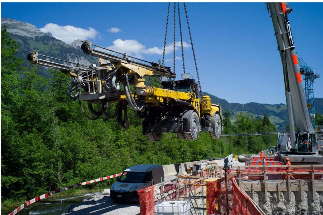
Abbildung 4: Bohrjumbo wird mit dem Pneukran für die Zeit während der Sprengungen aus der Baugrube entfernt und danach wieder hineingehoben.
