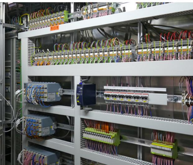
Die Mitarbeitenden im Geschäftsfeld Produktion erneuerten die Steuerung für Heizung, Lüftung und Klima in der Kraftwerkszentrale des Kraftwerks Unteraa in Giswil. Nach 25 Jahren war deren Software veraltet. Die drei verschiedenen Steuerungen wurden durch eine einzige, moderne Anlage ersetzt.
