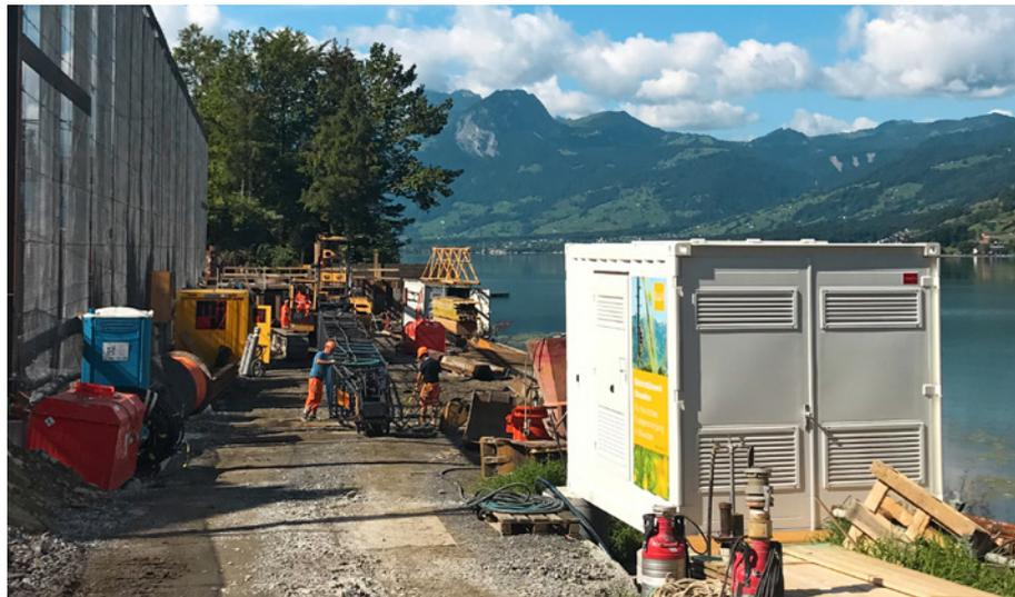
Für die Erschliessung der Baustelle beim Einlaufbauwerk Hochwasserschutz Sarneraa direkt am Seeufer in Sachseln kam nur eine mobile Transformatorstation in Frage. Sie ist in einem Container untergebracht und kann mit einem Kran verschoben werden. Diese liefert den Baufachleuten je nach Bedarf sowohl Mittelspannungs- als auch Niederspannungsenergie.
