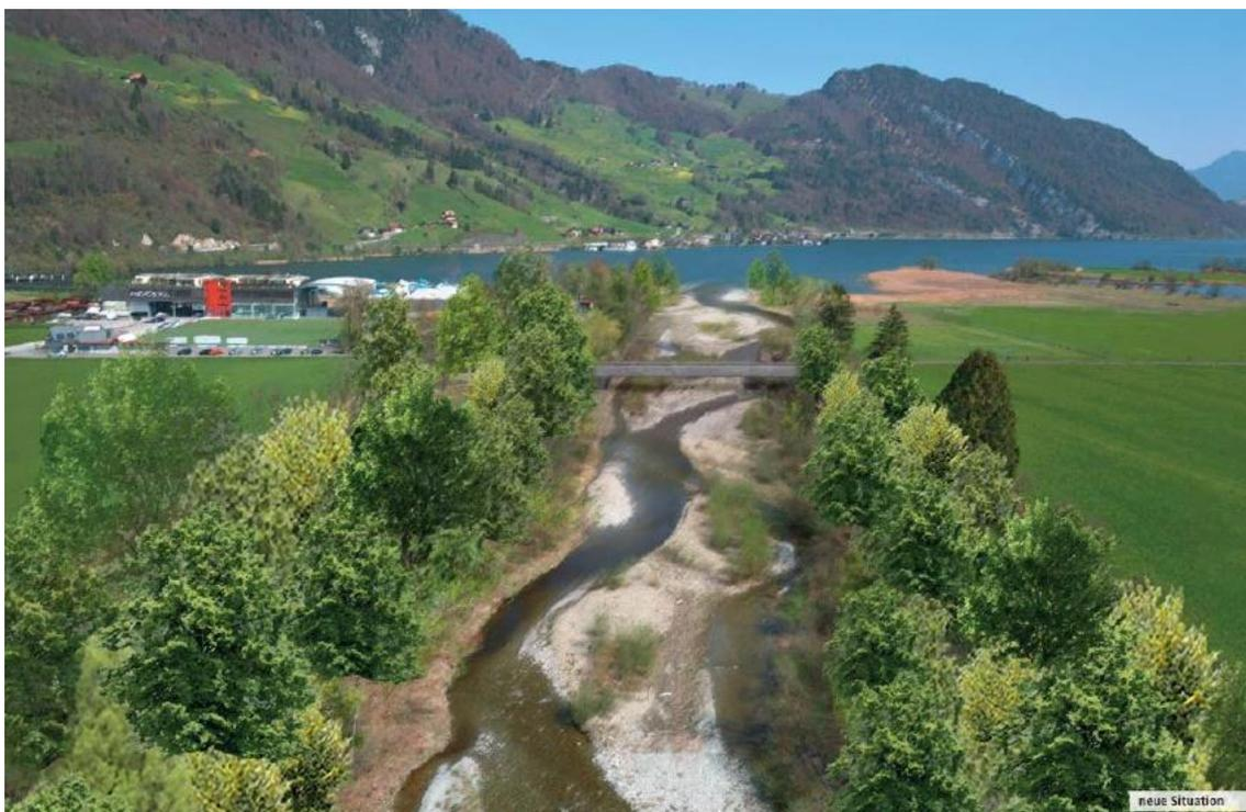
Abbildung 6: Visualisierung der aufgeweiteten Strecke bis zum See. Das Bachbett kann sich in dem Bereich eigendynamisch entwickeln. Das naturnahe Bachbett bietet Lebensräume für verschiedene Land- und Wasserlebewesen.
