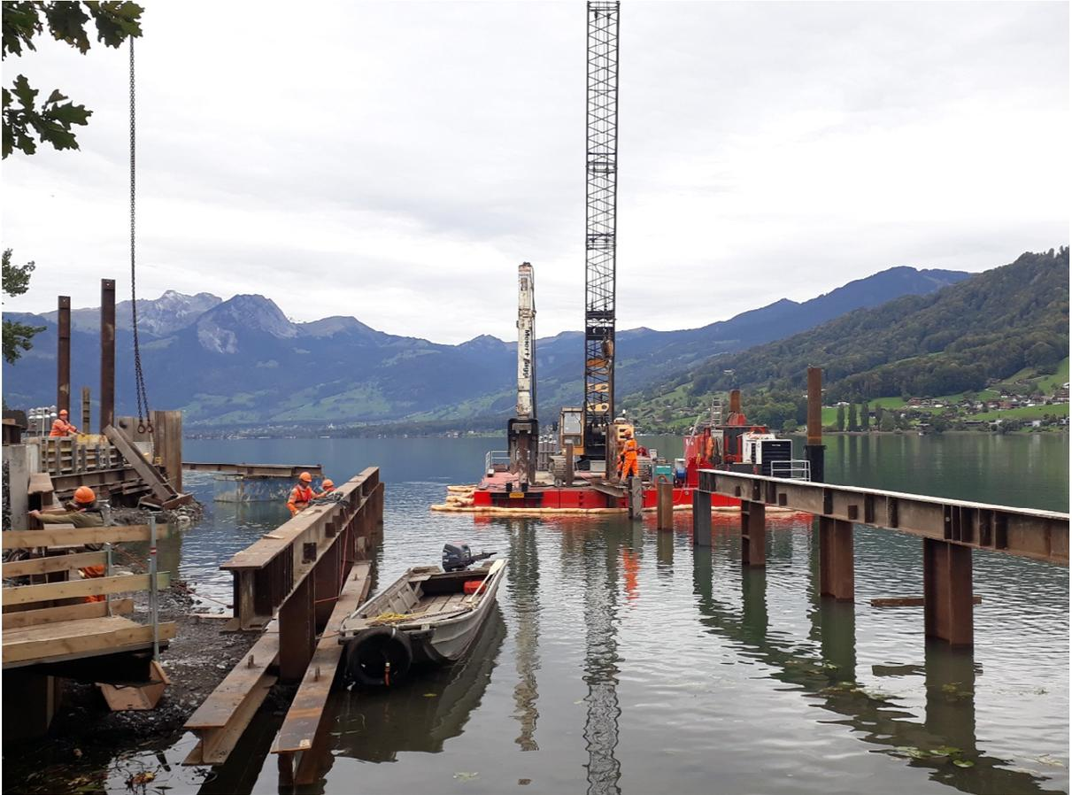
Foto 3: Die Baustelle für das Einlaufbauwerk des Hochwasserentlastungsstollens in Sachseln.
