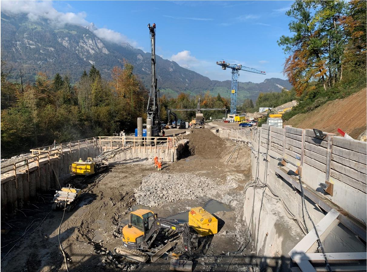
Foto 2: Die Baustelle für das Auslaufbauwerk des Hochwasserentlastungsstollens in Alpnach mit der Startgrube für die Tunnelbohrmaschine.
