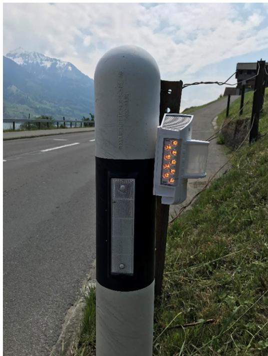
Bild 2: Mit zusätzlichem Wildwarngerät ausgerüsteter Leitpfosten. (Bild: AWL Obwalden)
