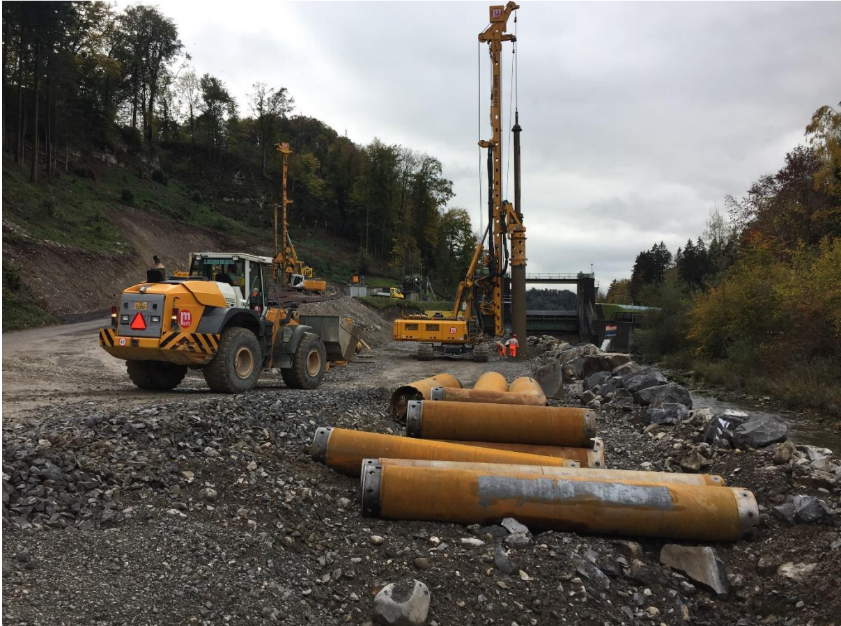
Grossdrehbohrgeräte im Einsatz. (Bild: Bau- und Raumentwicklungsdepartement Obwalden / 30.10.2018)
