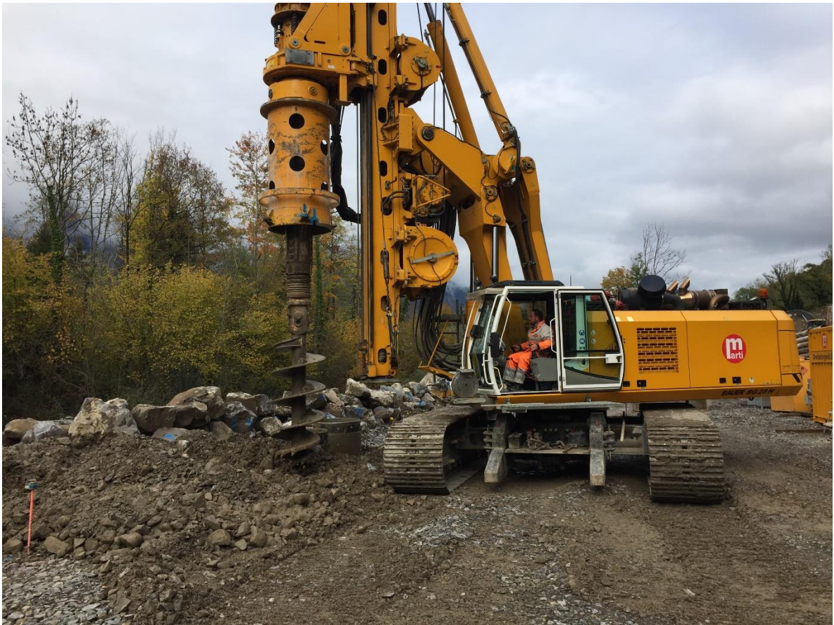
Führungseinrichtung mit Schneckenbohrer. (Bild: Bau- und Raumentwicklungsdepartement Obwalden / 30.10.2018)
