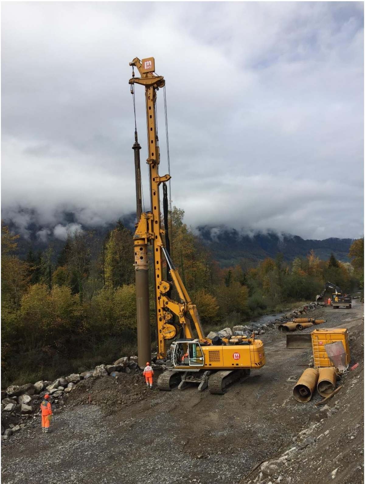
Grossdrehbohrgerät mit Mäklerführung (Führungseinrichtung). (Bild: Bau- und Raumentwicklungsdepartement Obwalden / 30.10.2018)
