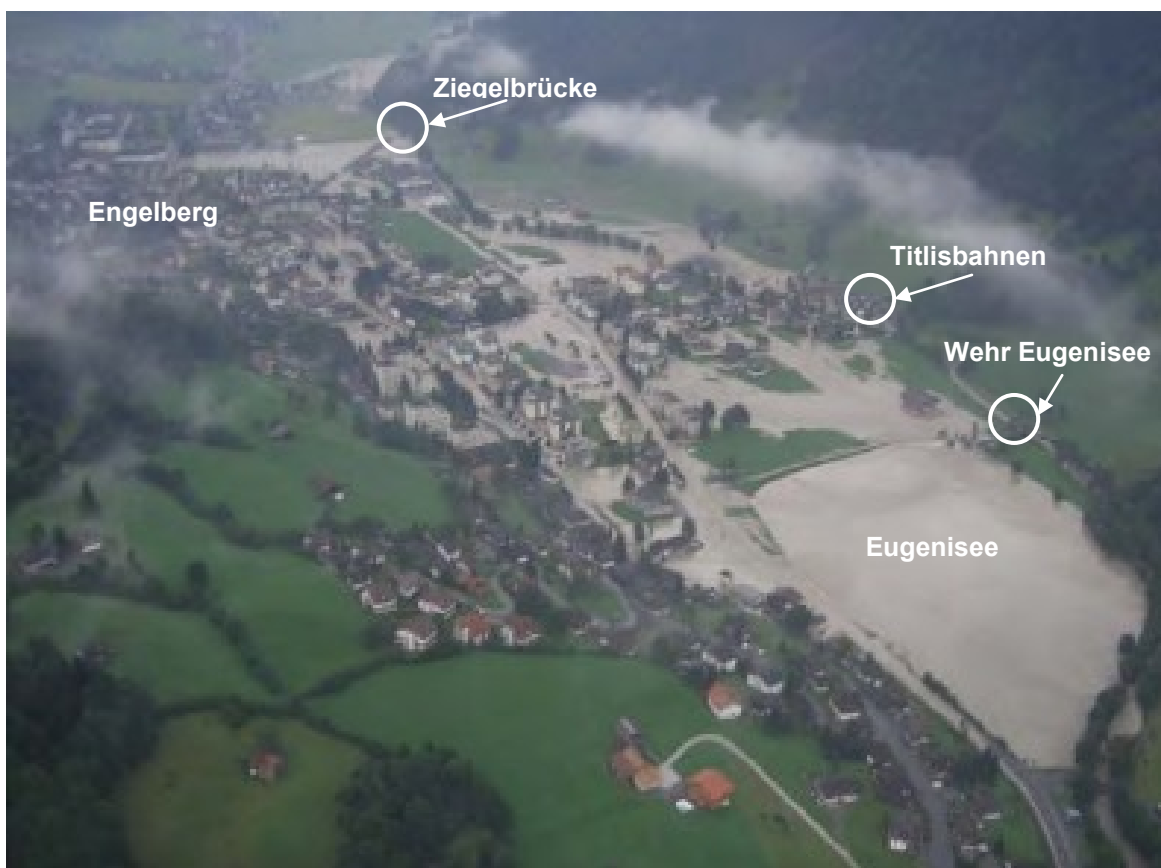
Abbildung 5.1: Hochwasser August 2005, Abflussverhältnisse, nachdem die Engelberger Aa die Ziegelbrücke zum Einsturz gebracht hatte
