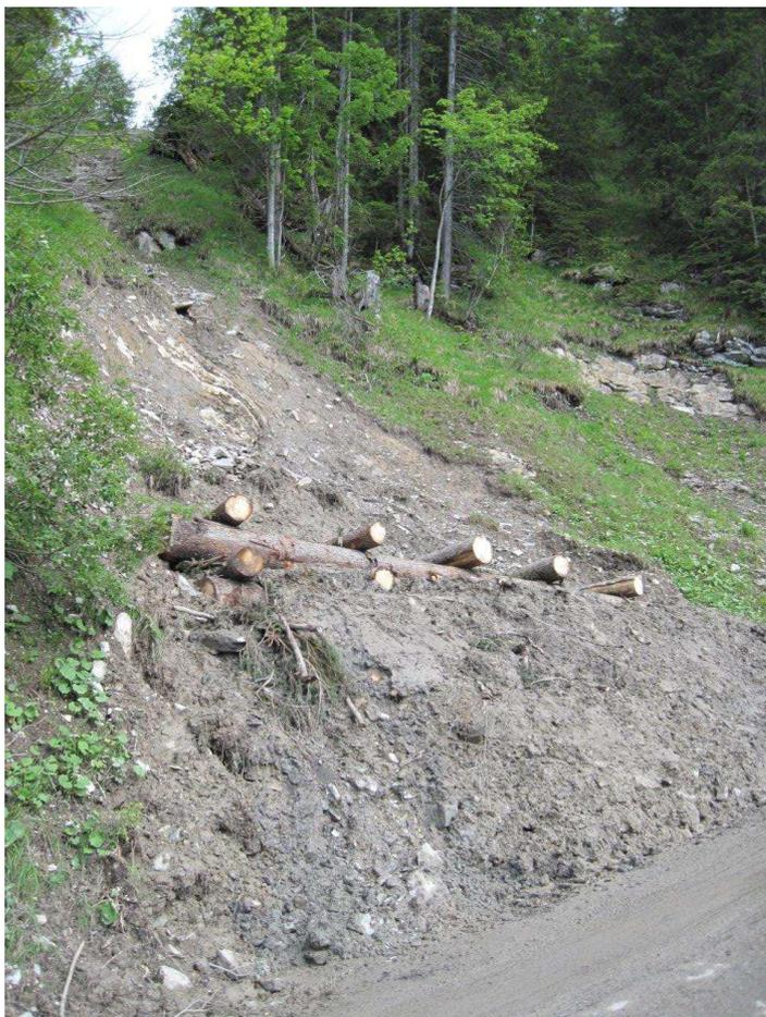
Abbildung 4: mit Holzkasten gesicherte Älggrasse, Schwandgraben, Sachseln (Foto 10.08.2015)
