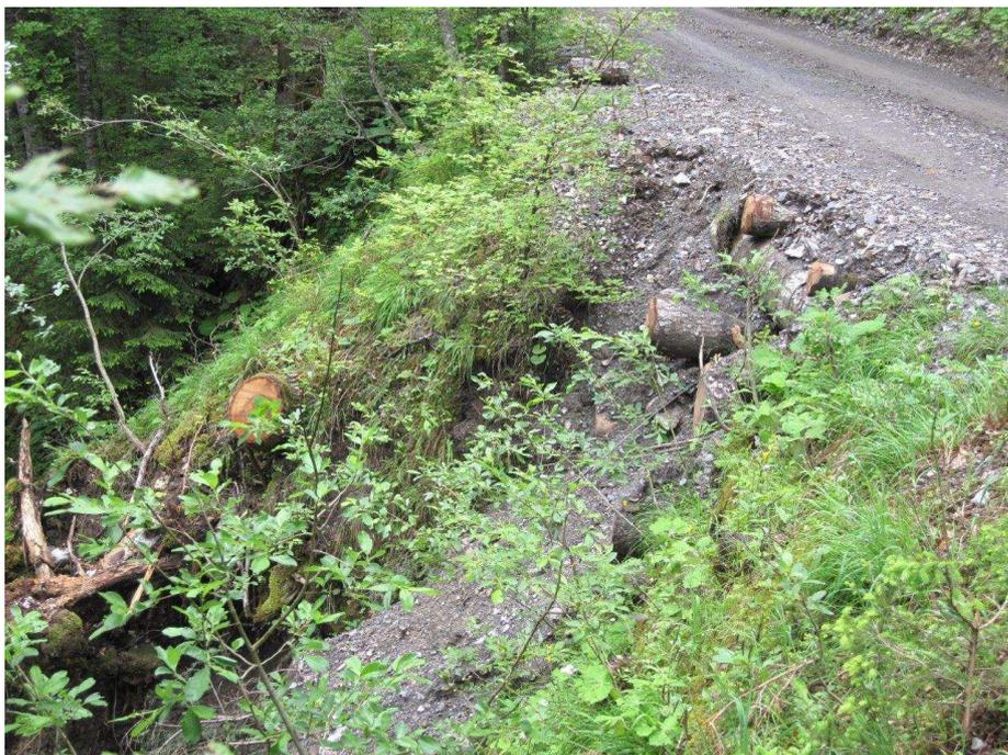
Abbildung 3: mit Holzkasten gesicherte Talstrasse, Wägiswald, Sachseln (Foto 10.08.2015)
