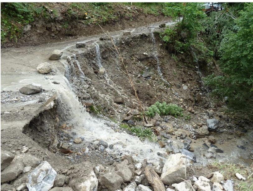
Abbildung 2: Stark untersülte Strasse und Furt Ebnetgraben, Kerns (Foto 08.06.2015)
