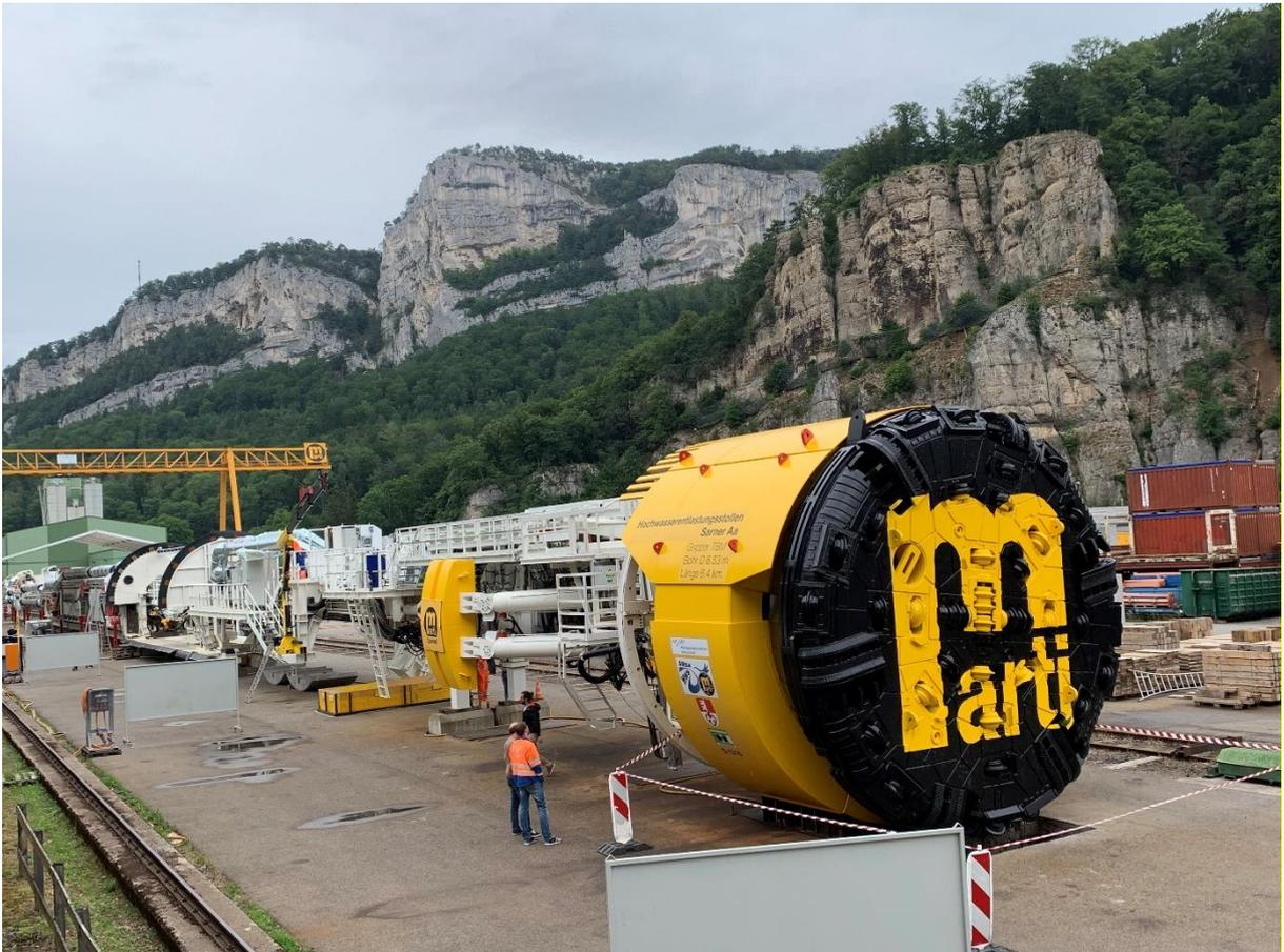
Bild 3: Vormontierte Tunnelbohrmaschine in Klus-Balsthal. Die Gesamtlänge der Maschine beträgt inklusive Nachläufer 150 Meter (Bild: Bau- und Raumentwicklungsdepartement Obwalden).
